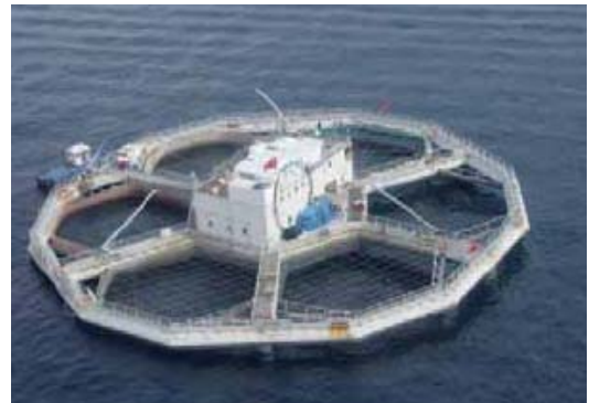
图15 配有六个大型网箱和中心2层工作楼的漂浮养鱼平台（意大利那不勒斯）
