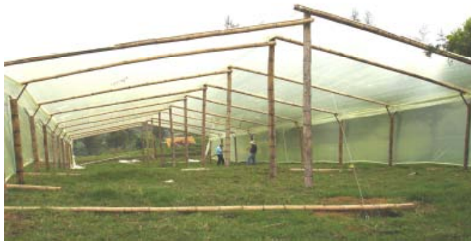
Figura 16. Invernadero en construcción en guadua
