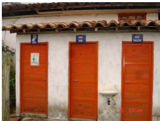
Figura 243. Baños para uso del personal que labora en el predio
