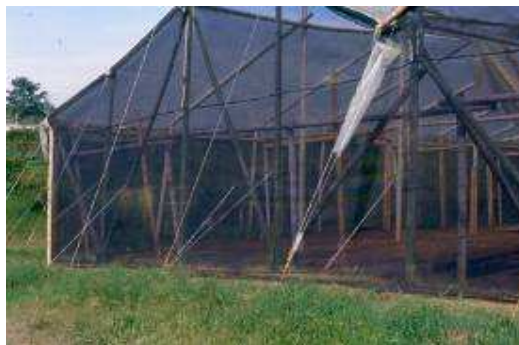
Figura 134. Invernadero con mallas antiinsectos
