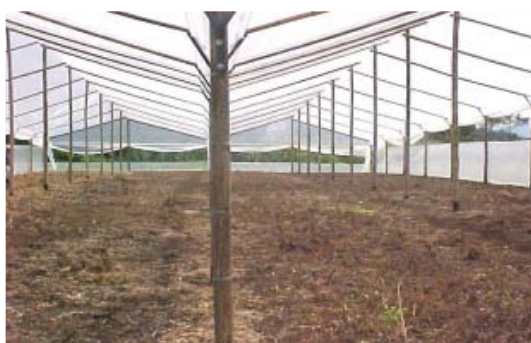
Figura 8. Invernadero construido con guadua y cobertura plástica
