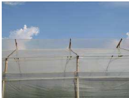
Figura 62. Invernadero con apertura fija en la cumbre
