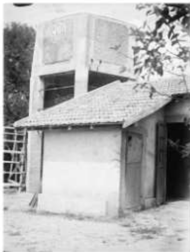
Le château d'eau et l'usine électrique
