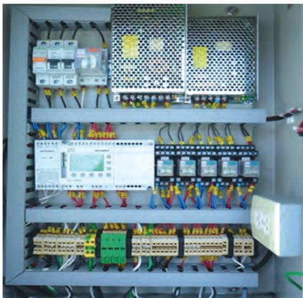
Figura 7. Programador Lógico Controlable (PLC).
