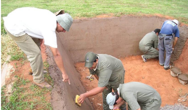
Foto N° 19. Estanque impermeabilizado con suelo-cemento.
