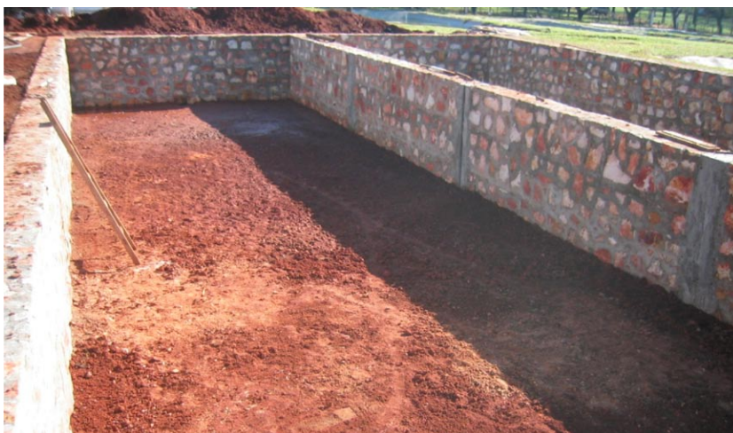
Foto N° 15. Estanque construido de Mampostería o piedra.
