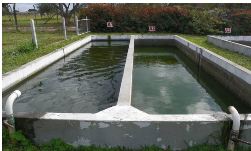
Foto N° 16. Estanque construido de concreto.
