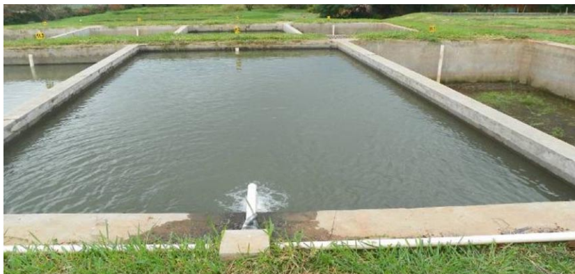
Foto N° 14. Estanque construido con material de mampostería
