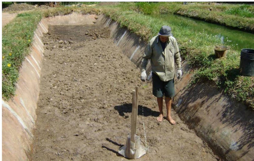
Foto N° 23. Estanque con reposición de arcilla en el fondo, para su mantenimiento.
