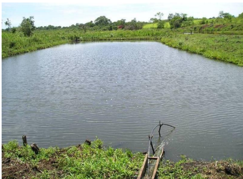
Foto N° 17. Estanque construido en suelo arcilloso.
