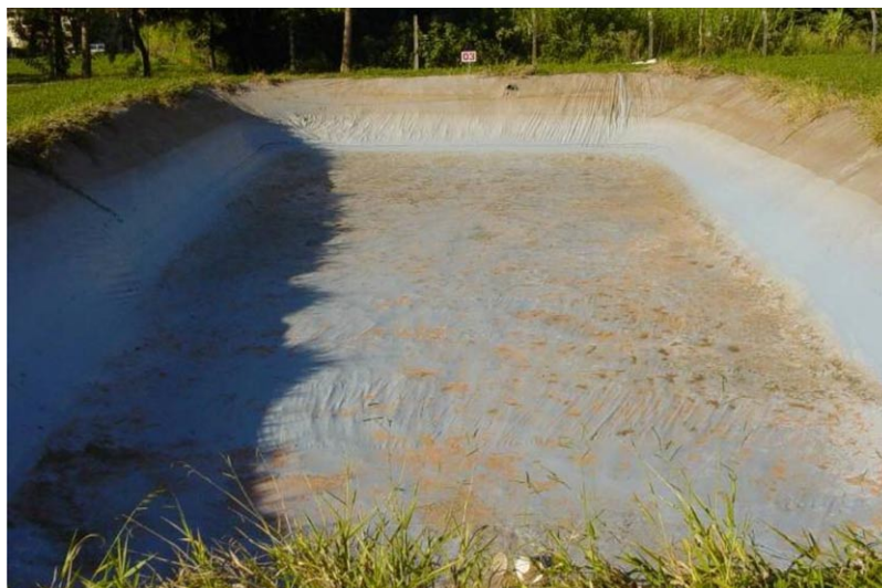
Foto N° 18. Estanque impermeabilizado con material plástico.
