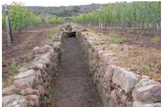
Muro de piedra en seco y cana de drenaje – Finca La Piana
