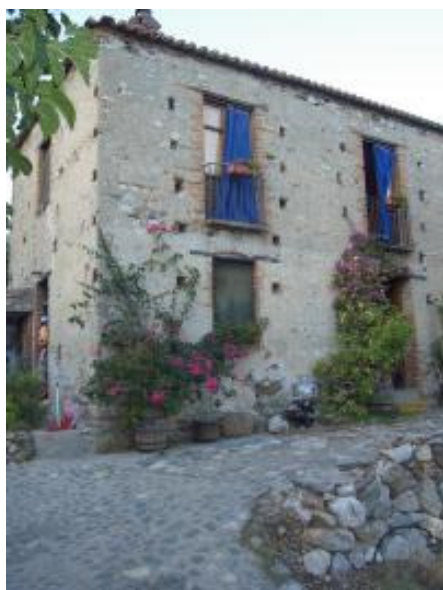
Edificio de la finca “Il Bergamoto”
