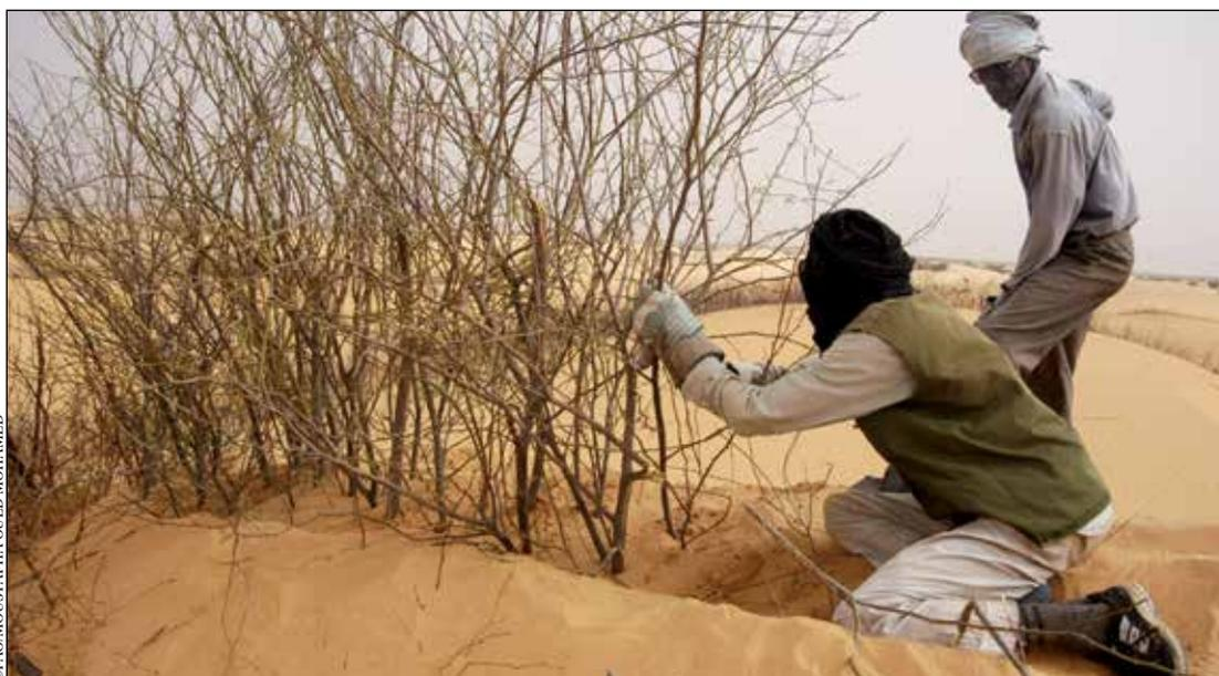
**Instalación de una empalizada para la estabilización mecánica de las dunas (Mauritania)**
