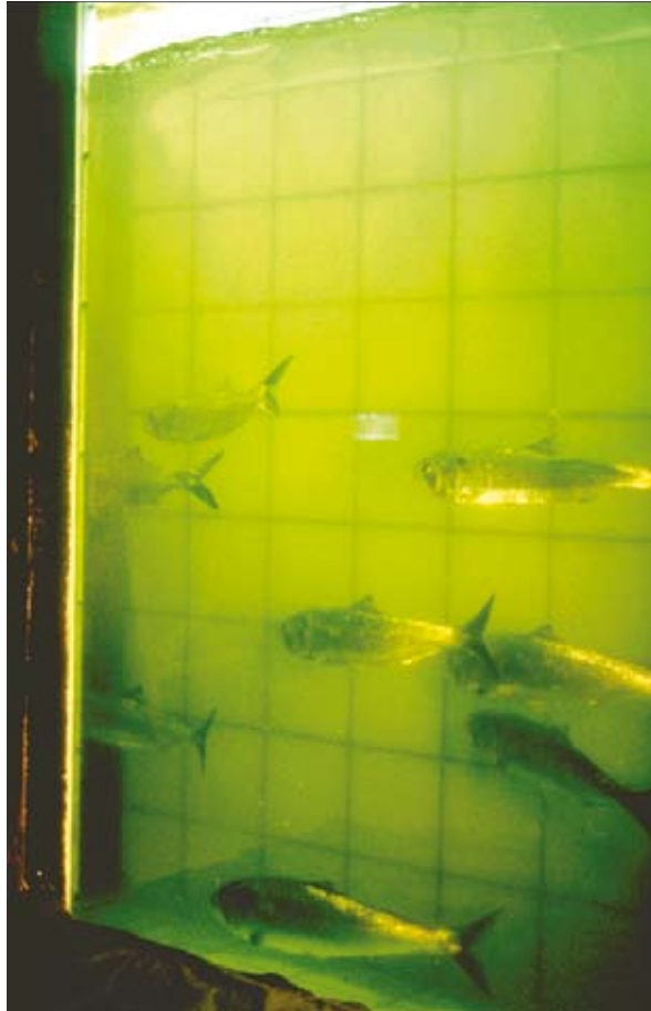
照片22: 欧洲西鲑通过多尔多涅河（法国）上图伊列雷斯升鱼机的计数室（Larinier摄）
