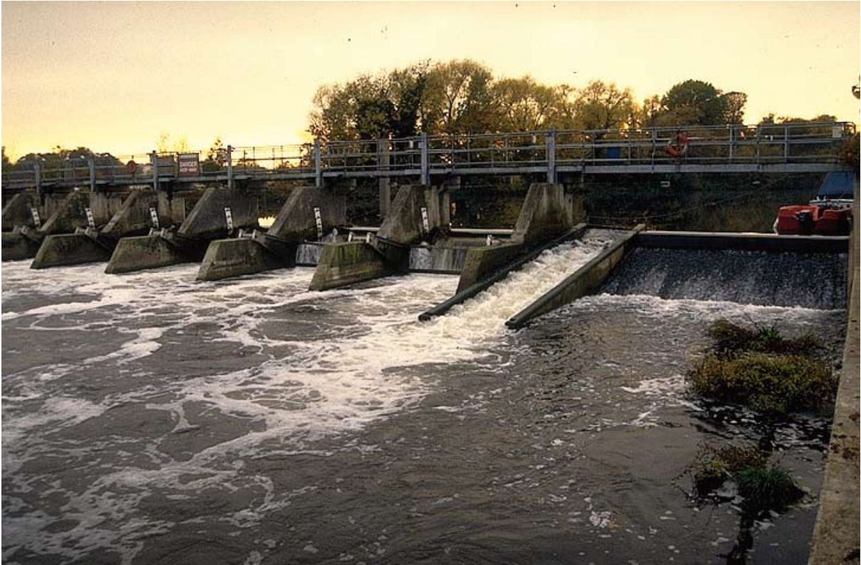
照片12: 泰晤士河上有底板-隔板的鱼道 (Larinier摄)
