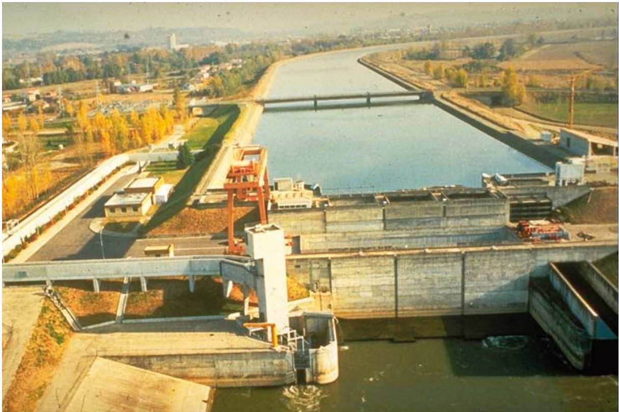
照片15: 戈尔费奇大坝 ( \Delta h = 17 米) 上的升鱼机每年通过数以千计的欧洲西鲱，因而有助于恢复加龙河（法国）中与上游重要产卵场隔绝了的欧洲西鲱种群（Larinier摄）
