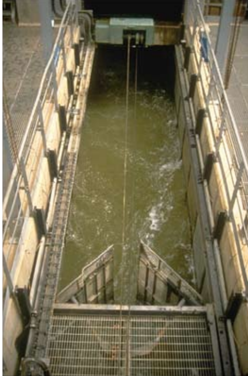
照片16: 加龙河戈尔费奇大坝上升鱼机中的暂养池和集鱼器 (Larinier摄)
