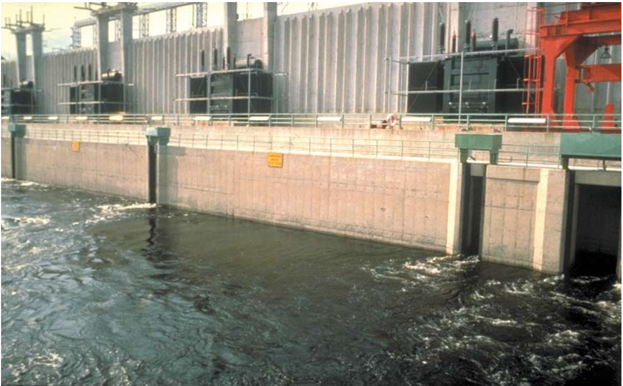
照片20: 麦克塔奎克电站涡轮机尾水管上的集水道 (加拿大圣约翰河) (Larinier摄)
