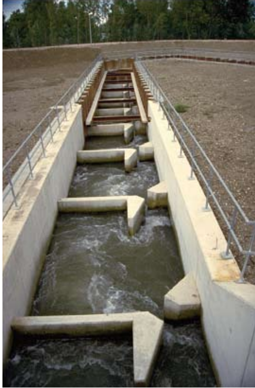
照片10: 莱茵河伊费热伊姆大坝上的鱼道是欧洲最近建造的垂直狭槽鱼道之一, 连同入口建筑物, 37个水池有助于鱼通过10米高的障碍物 (Larinier摄)
