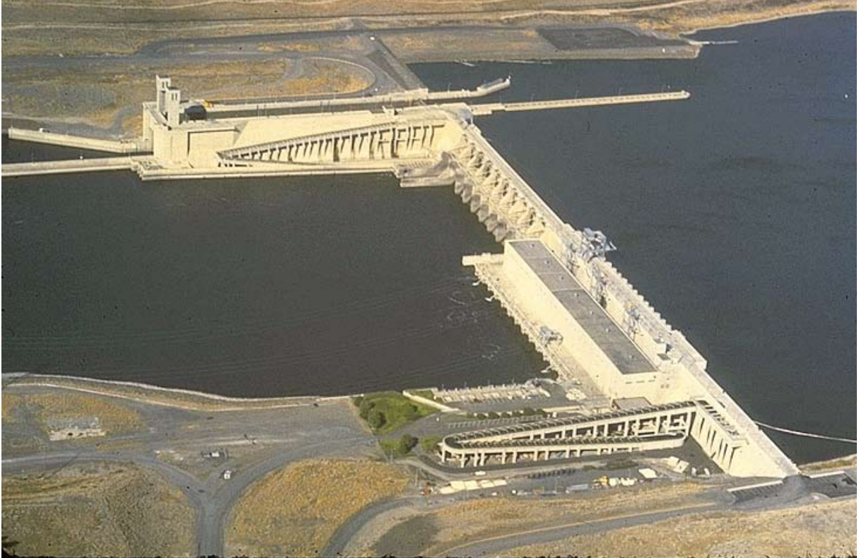
照片19: 哥伦比亚河上艾斯港大坝全视图, 该图显示发电厂处的第一条鱼道和集水道及溢洪道处的第二条鱼道。鉴于该河流流量为2800米 3 /秒, 溯河鱼类设施不同入口处的流量相当于河流总流量的2.6% (即72米 3 /秒) (Larinier摄)
