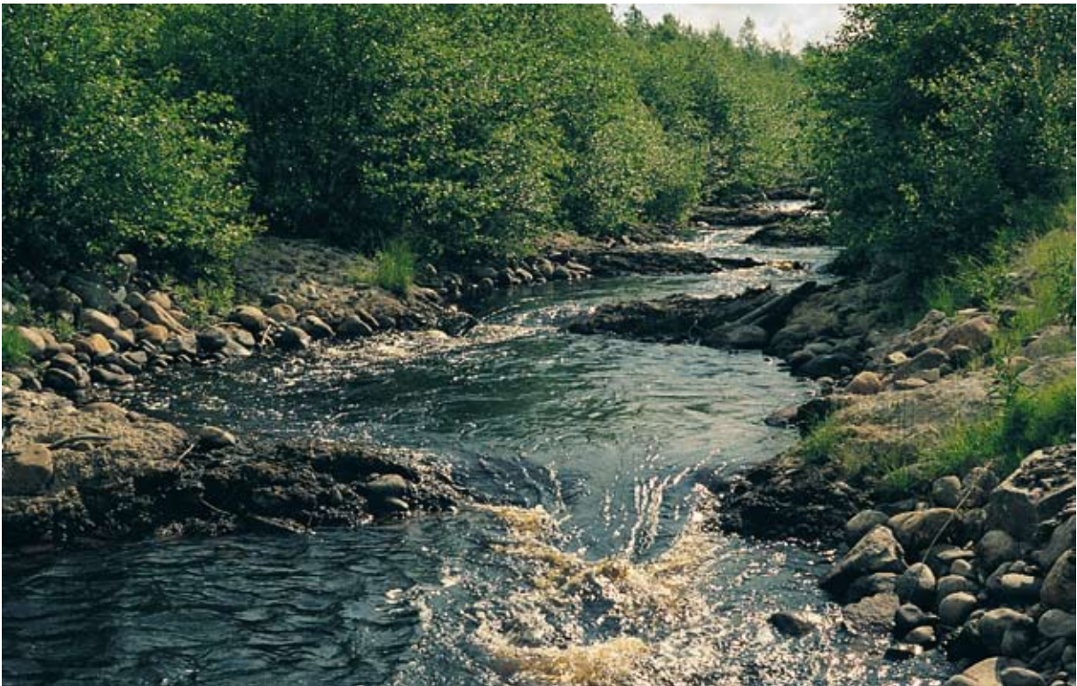
照片14: 在锡卡河 (芬兰) 修建了一条鱼道作为绕坝的人工河; 在20个自然水池 (两个水池间的落差 \Delta h = 0.2 米) 中能量是渐渐耗散的, 河七鳃鳗、鲈、白斑狗鱼能克服4米高的坝游到上游 (Marmulla摄)
