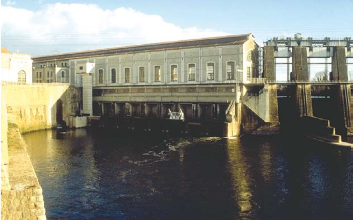
照片27: 由于多尔多涅河（法国）图伊列雷斯大坝上有升鱼机，洄游性鱼类如鲑和欧洲西鲱能够过坝并到达更上游的产卵场（Larinier摄）
