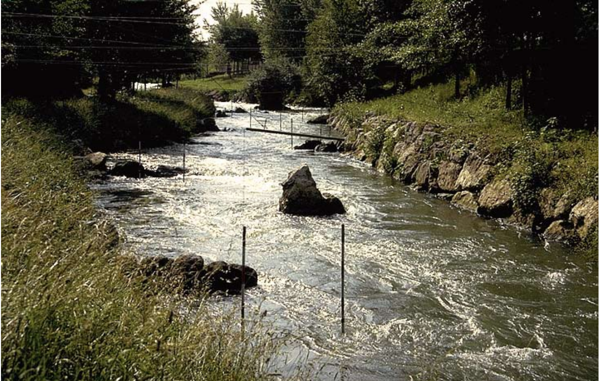
照片13: 为克服一个5.5米高的坝在波河上修建了这个具有自然特征的旁路水道, 经评定该鱼道的效率对鲑为100% (Larinier摄)
