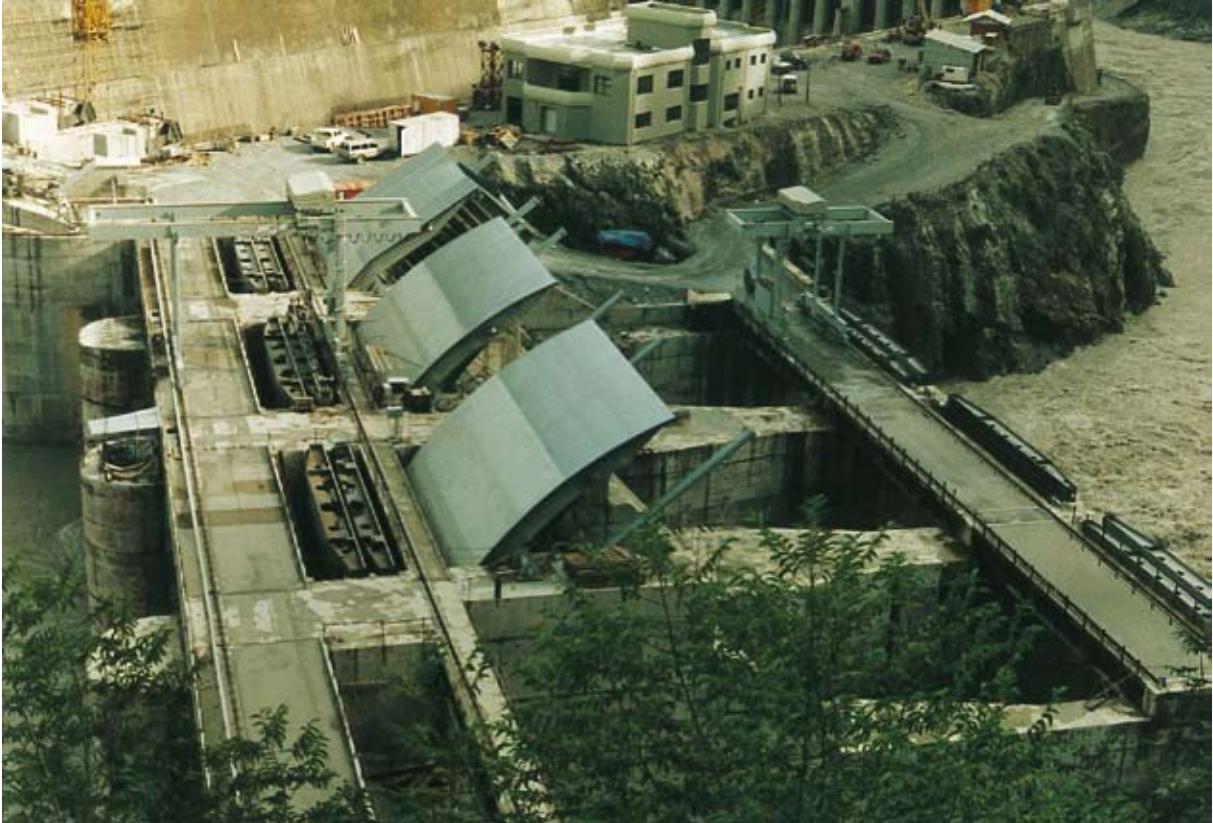
照片3: 2001年仍在施工中的44米高的卡利甘达基“ A ”型水电大坝（尼泊尔），阻断了当地鱼类如结鱼（ Tor sp. ）和鱼丕（ Bagarius bagarius ）到达其上游重要产卵场（Marmulla摄）
