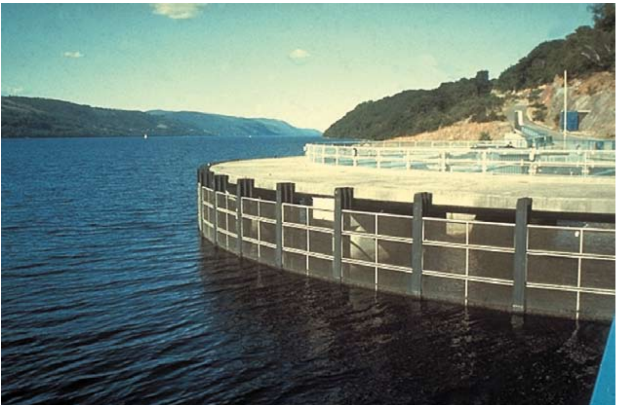
照片24： 苏格兰内斯湖上水力发电厂进水口处的细网目栅栏（Travade摄）
