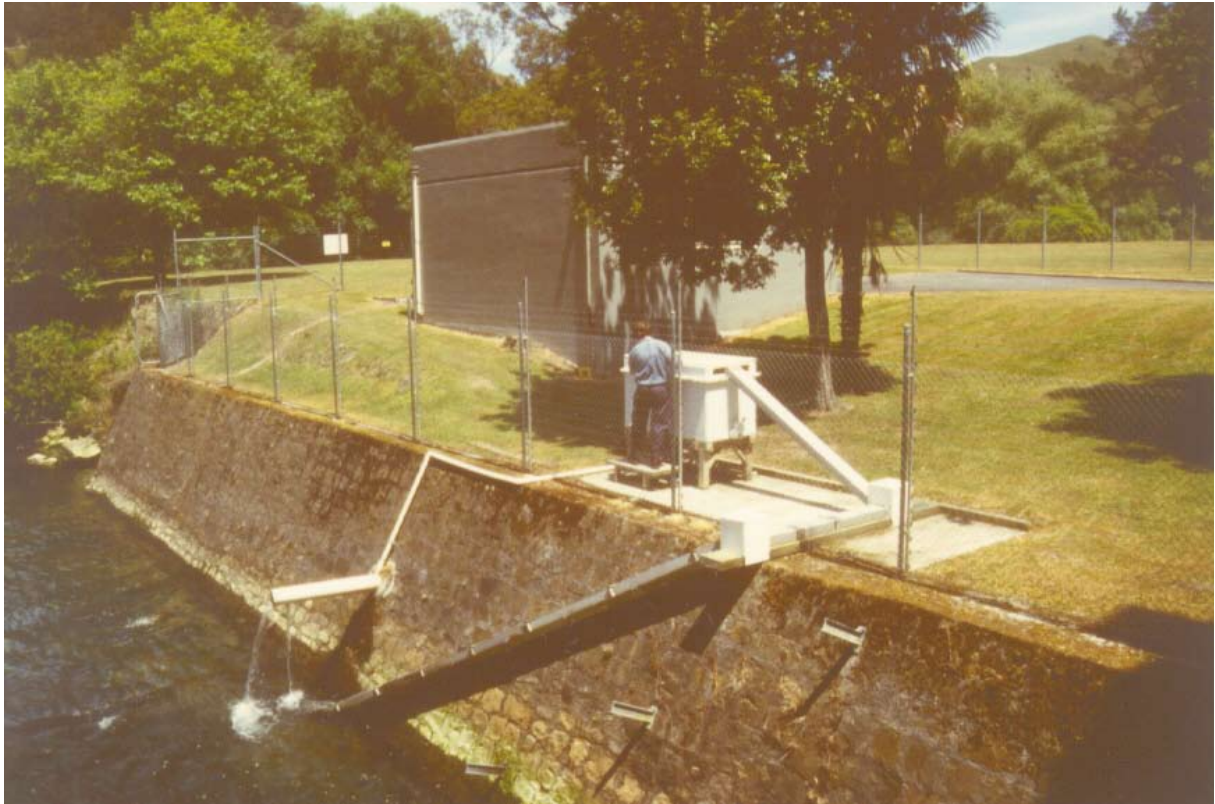
照片18: 怀卡热塔赫克河皮里帕瓦发电站旁的幼鳗陷阱网 (Larinier摄)
