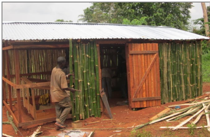
Image 3 : Construction de l'hangar et squelette du propagateur dans le site pilote de Mbaïki, RCA (Photo : Bruno Bokoto de Semboli)
