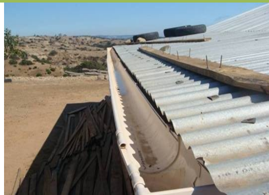
Cosecha de aguas lluvias a través de canaleta instalada en el techo de una casa y estanque para recolección. (fotos: INIA)
