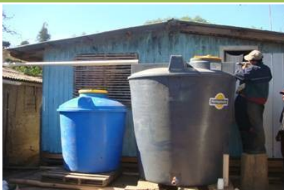
Cosecha de aguas lluvias a través de canaleta instalada en el techo de una casa y estanque para recolección. (fotos: INIA)
