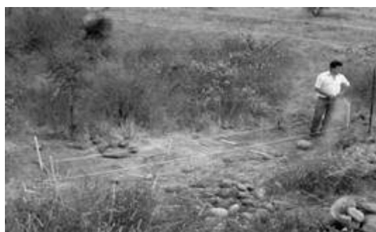
Uso de pircas al interior de una cárcava para reducir el flujo de agua. Trazado de la base para la construcción de pircas. (fotos: INIA)
