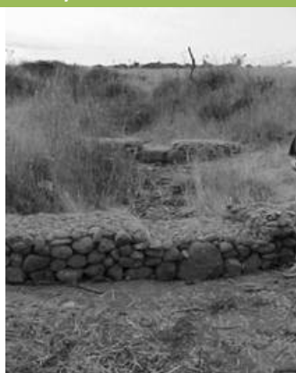
Uso de pircas al interior de una cárcava para reducir el flujo de agua. Trazado de la base para la construcción de pircas. (fotos: INIA)
