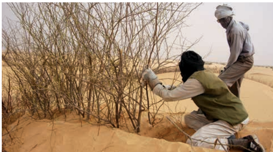
Instalación de una empalizada, estabilización mecánica de las dunas, Mauritania
