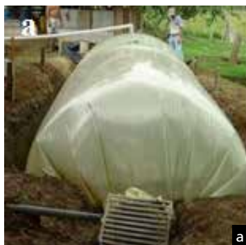
Figure 4 Différents matériaux utilisés pour la construction de biodigesteurs : a) gaines en plastique ; b) briques ; c) béton ; d) bidon recyclé en plastique ; e) bidon recyclé en métal ; f) préfabriqués
