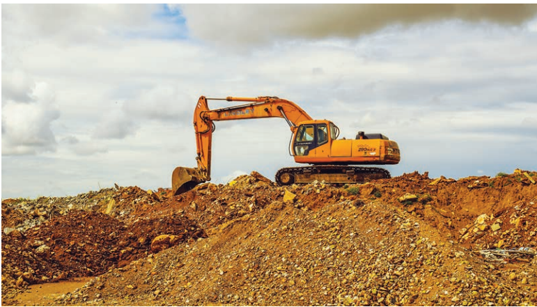
图21 浮动式挖掘机作业 (Pxhere)
