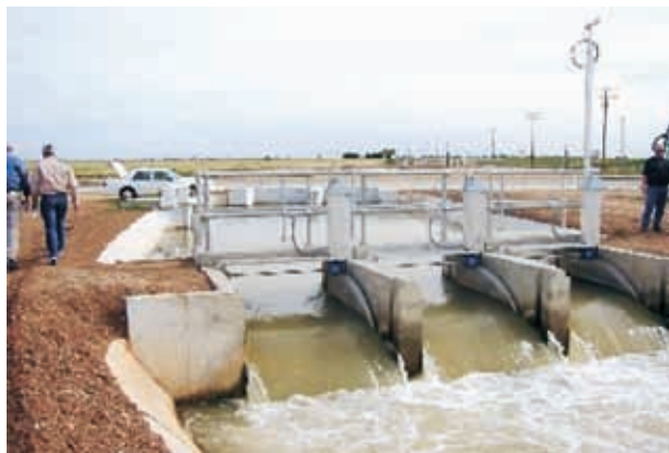
图 31 美国加利福尼亚州，帝王灌区：装有三个卢比肯闸门的调节阀
