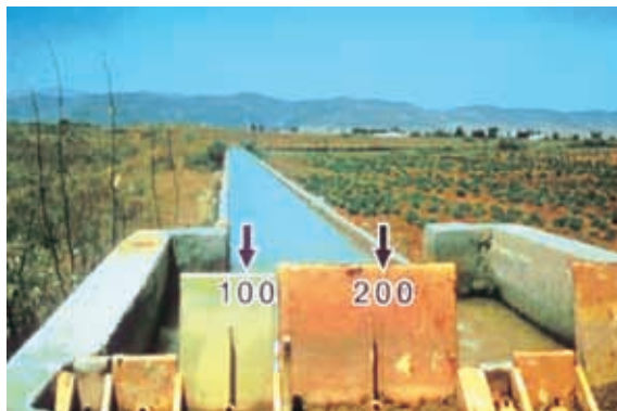
图 10 摩洛哥，doukkala 项目：模块化分配器输送恒流量
