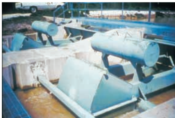
图 9 浮动式上游水位控制自动闸门
