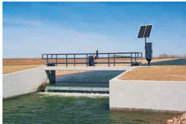
图 22 加拿大，艾伯塔：自动上射式闸门
