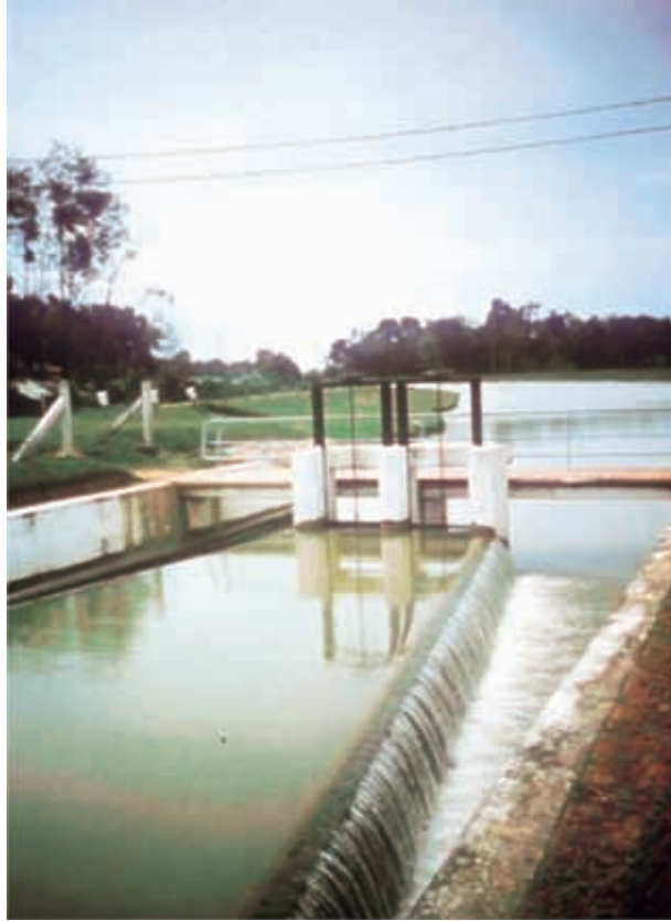
图 16 马来西亚，Kemubu 项目：非常好的综合调节器实例——长顶溢流堰与两个闸门联在一起，用于控制淤泥和水流变化
