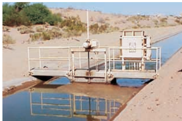
图 23 美国加利福尼亚州，尤马灌区：使用现场控制器的 SCADA 点
