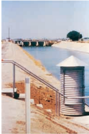
图 18 美国加利福尼亚州，弗里恩特—克恩运河： 支路排水渠 littleman 控制器
