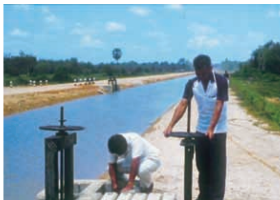
图 1 泰国，湄干灌溉项目：了解甚少的恒流头孔的运营
