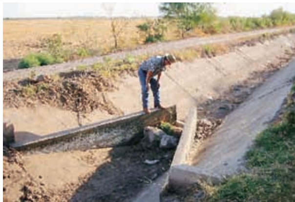
图 32 墨西哥，mayo 灌区：被破坏的长顶堰，很大可能是因为没有遵循上游控制操作的基本原则
