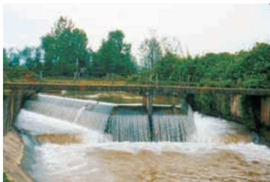
图 13 斯里兰卡：简易长顶溢流堰调节阀
