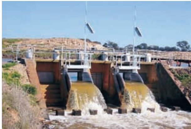
图 30 澳大利亚，墨累达令流域：装有两个卢比肯闸门的调节阀
