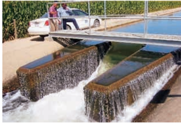
图 14 美国加利福尼亚州，Turlok 灌溉地区：双长顶溢流堰
