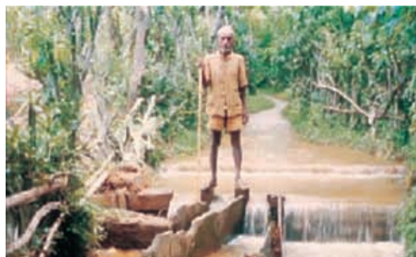
图4 尼泊尔：按照比例分配的原则，使用流量分配器的传统灌溉系统
