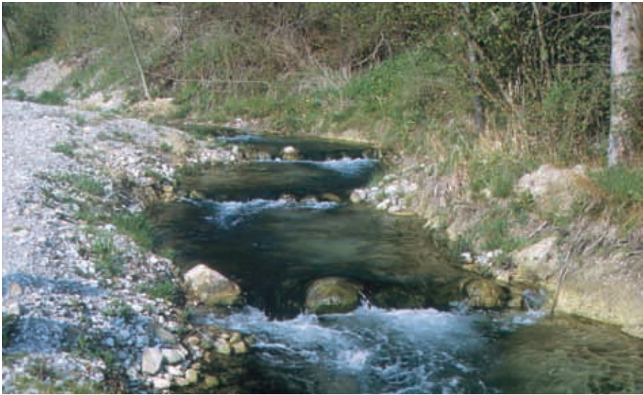
图 4.45 莱希河金绍坝附近的鱼溪。其陡坡被用蛮石制做的横槛中断。槛间盆状构造的底未加固，经过冲刷能形成水池
