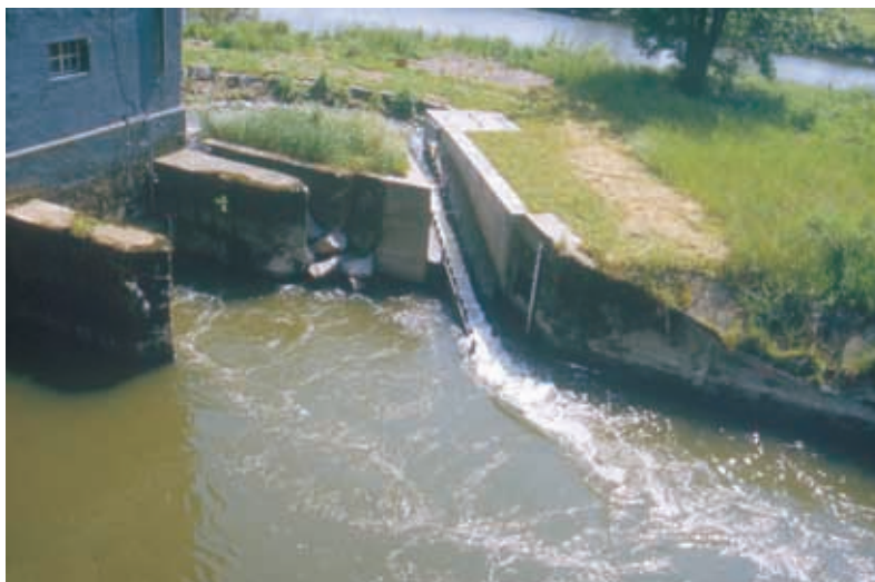
图 5.36 下丹尼尔通道及之上的休息池视图。吸引流清晰可见，其在尾水渠处有大范围的影响面积，同时使鱼道入口易于被发现
