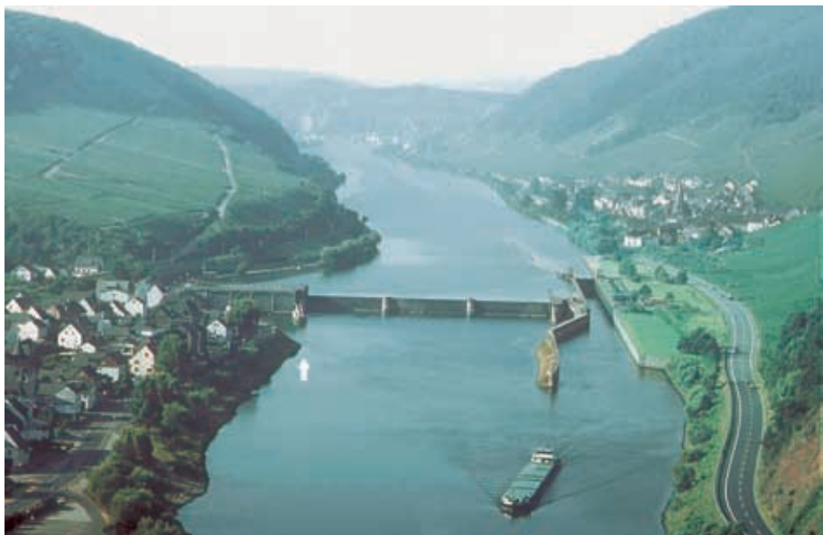
图 3.3 摩泽尔河（莱茵兰-法尔茨）上尼夫坝的鸟瞰图，显示与坝的总体大小相比鱼道的大小（白箭头）。
