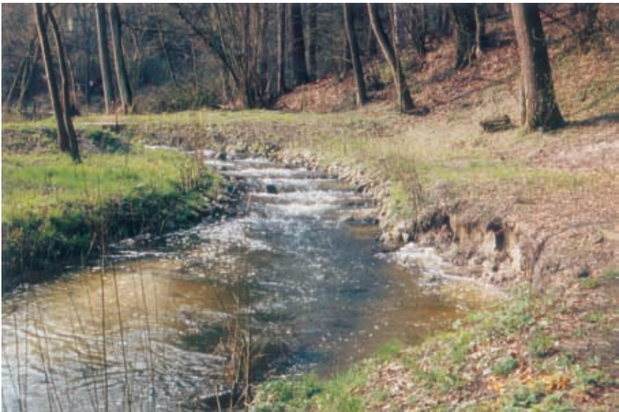
图 4.24 塞弗特氏磨房旁的旁路水道。卵石槛的加固段和未加固段交替产生高度可变的流动状态。可让零坡度区听任其自然改变。照片前景显示倾斜岸切割，但这并未危害卵石槛的设置
