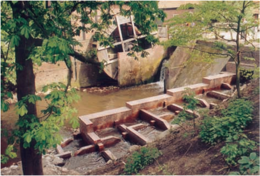
图 5.3 在贝尔讷河（下萨克森州）胡德磨坊坝附近用砖建造的、具交错水池的水池式鱼道。该建筑物与过去磨坊总画面非常相配
