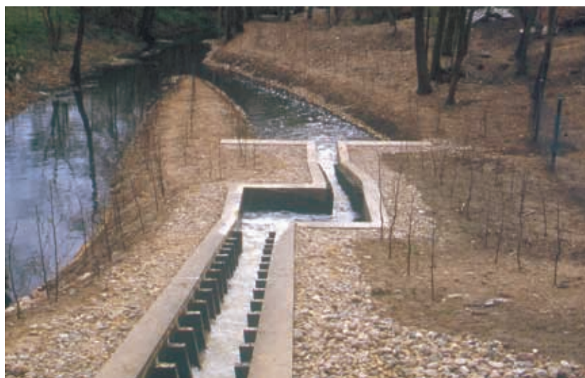
图 5.29 有中间休息池的丹尼尔鱼道。普伦茨劳（勃兰登堡）附近的戈尔米茨磨坊/河的上游水平视图
