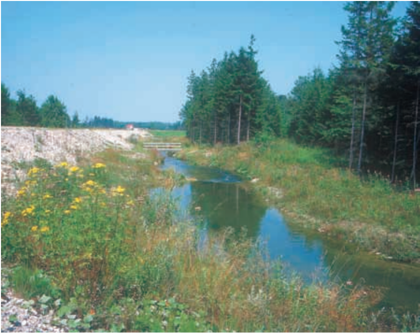
图 4. 26 主堰下旁路水道与老河床连接。为了便于操作，使老河床的最低流量为 20m 3 /s。照片显示莱希坝旁路水道在金绍的上游段。这一区段施工坡度平缓，不加固水道横截面即可获得波状结构。在下游段克服最大高度差，下游段的构造呈阶流式，坡度为 I=1：20～1：30。流量由旁路水道的入口构造控制，该入口构造床具有保护旁路水道免于洪患之功能，主电站旁若再加设一鱼道则可大大改善这个堰附近的环境
