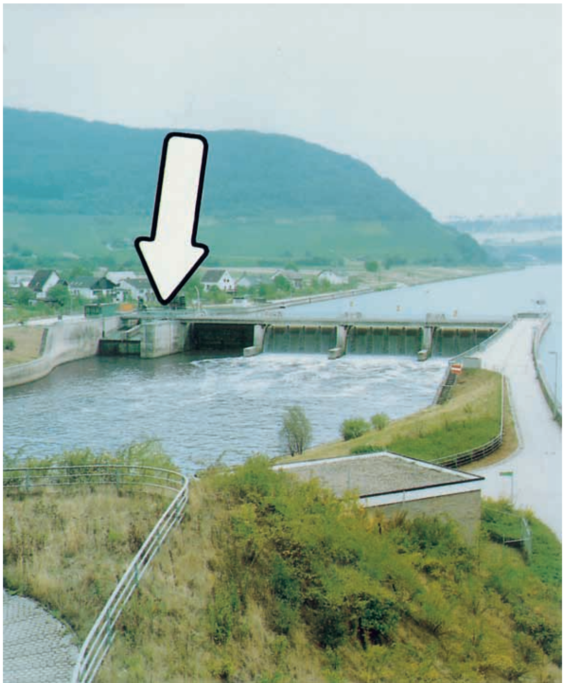
图 5.44 舍登/萨尔鱼闸（堰整体图）。鱼闸安装在堰和发电厂间的隔墩中（见箭头）。
