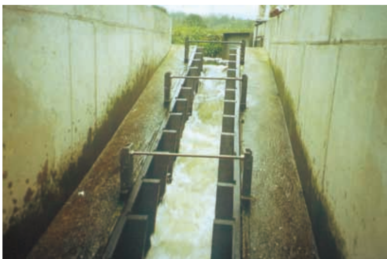
图 5.37 下丹尼尔通道视图。混凝土制通道覆盖有木板，木板上安装有呈 U 形开口的隔板。水面上的高湍流度水气混合物令观察者误解，然而通道底区附近的流速实际上低得多
