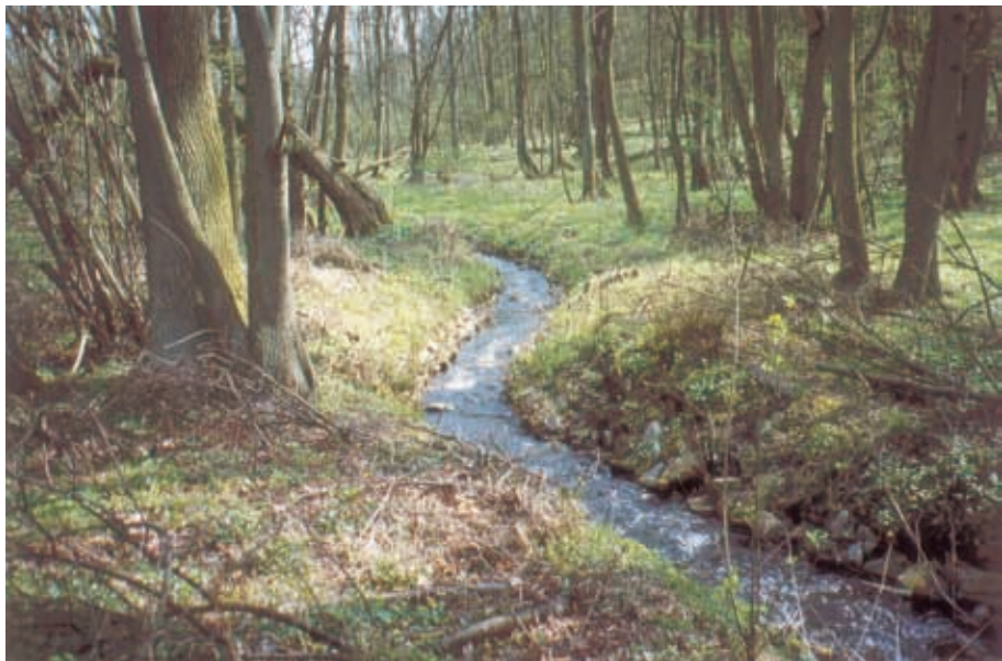
图 4.17 旁路水道使得采用贴近自然的构造及与水道所在地点很好地融合成为可能。 本例中，水道的线形是依原有植被而定的。拉普瑙磨坊（勃兰登堡）
