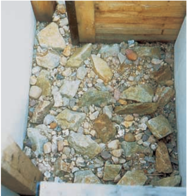
图 3.14 狭槽鱼道中的粗糙底质，下施普雷瓦尔德地区的下普赫尔河堰（勃兰登堡）
