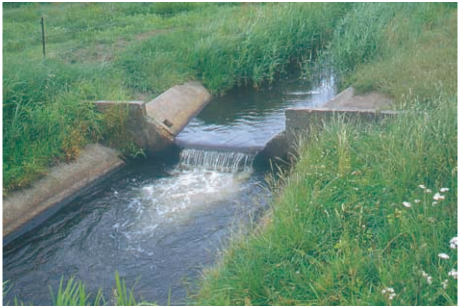
图 3.1 本图所示的跌水，即使不很高，也对小鱼的洄游是一个不可逾越的障碍。 位于加尔德莱根的劳格溪（萨克森-安哈尔特）
