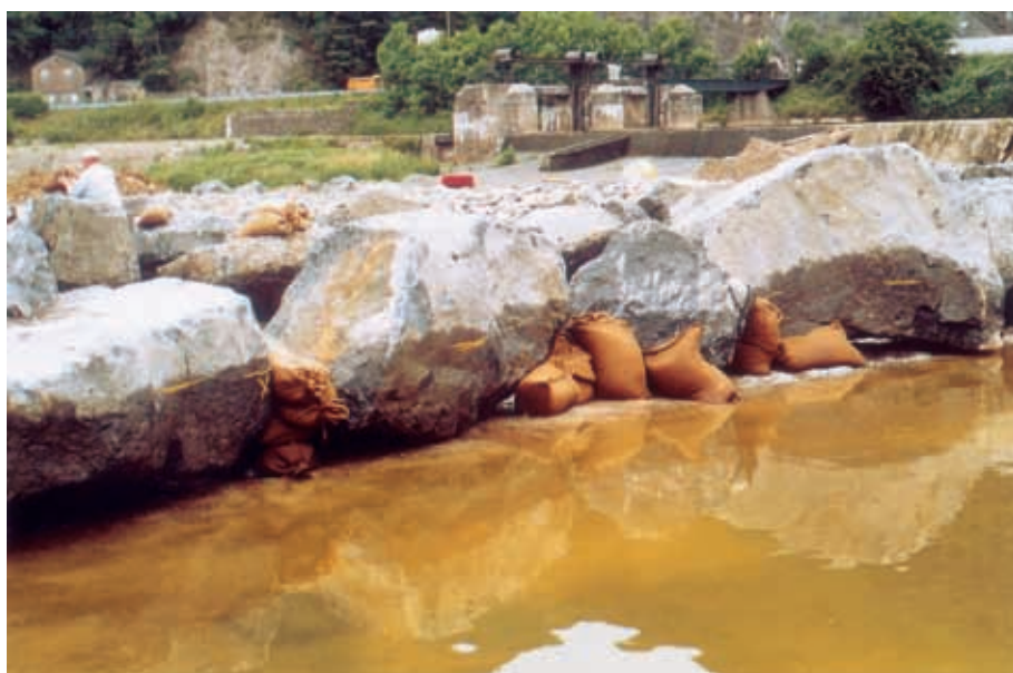
图 4.49 艾托夫—温克尔米勒鱼坡的试运行，不可能精确设计计算这类不规则蛮石堰。因此，蛮石的最佳排列在这里最初是借助于沙袋。在这次试验后，蛮石才被固定。必须认为这类试运行是施工过程的一个必不可少的部分，因而在设计阶段其成本就已被考虑
