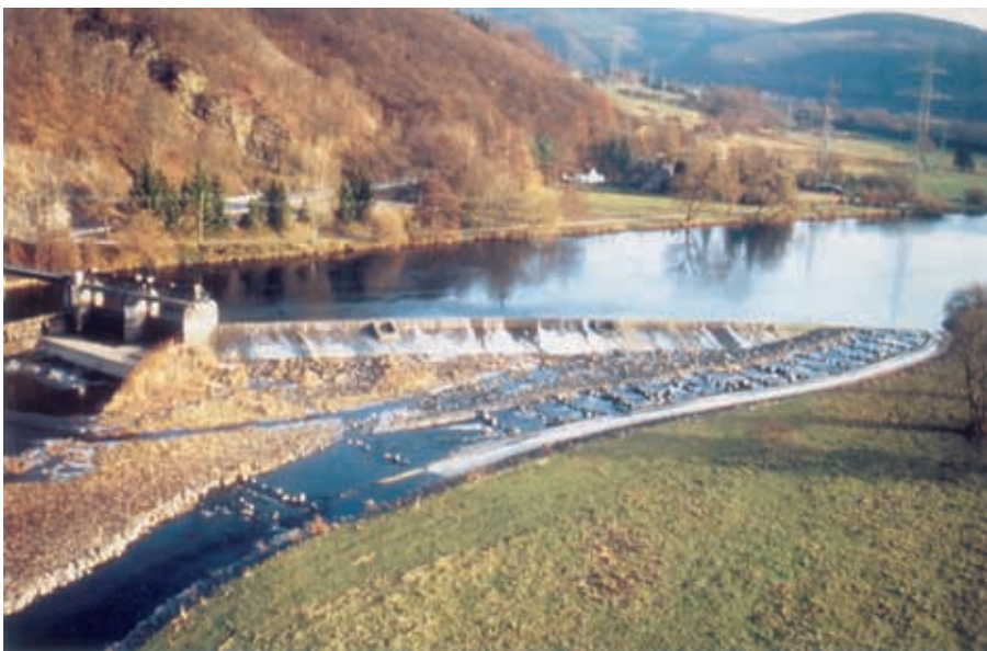
图 4.29 鱼坡在旁路电站主堰附近的位置。正常情况下，最低总流量通过鱼坡传送。水仅在流量较高时才溢出堰。齐格河（北莱茵-威斯特法伦州）上的艾托夫鱼坡
