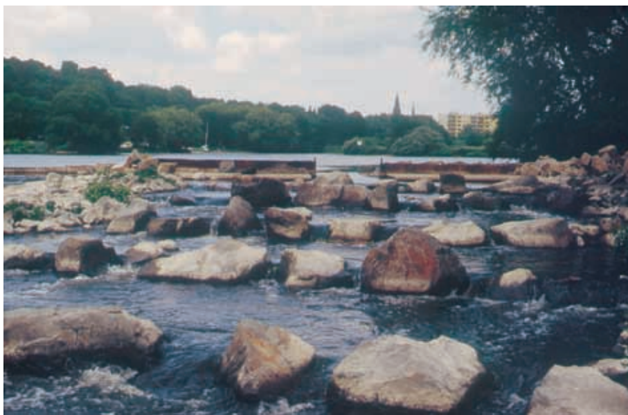
图 4.41 斯皮伦堡堰；竣工后的鱼坡
