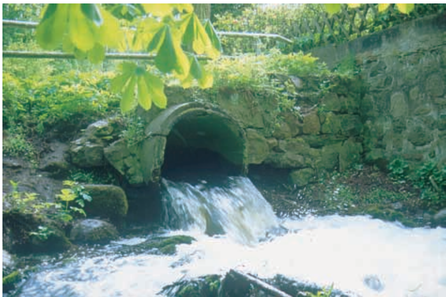
图 3.2 具冲刷邻近溪底的射流涵洞是水生物洄游不可逾越的障碍。位于斯托贝尔的普里奇哈格内尔磨坊（勃兰登堡）
