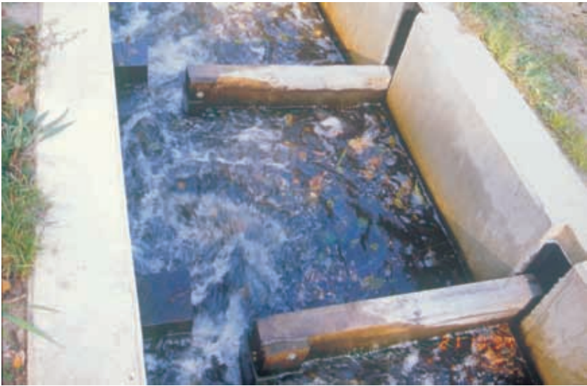
图 5.20 狭槽鱼道中的狭槽流。水流必须从狭槽沿对角线形成，防止水池中的短路流（下普赫尔河坝/下施普雷瓦尔德）
