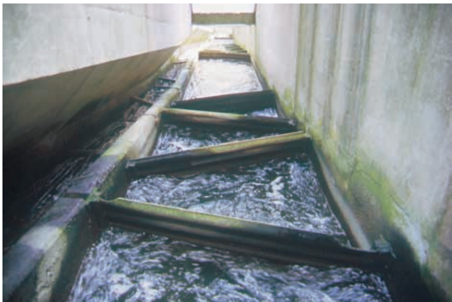
图 5.40 罗斯波特（莱茵兰-法尔茨州）附近绍尔坝上的长菱形鱼道和鳗鲡梯。 上游水视图。鳗鲡梯内放置了柴捆，平行设置于长菱形鱼道靠河岸一方的边墙
