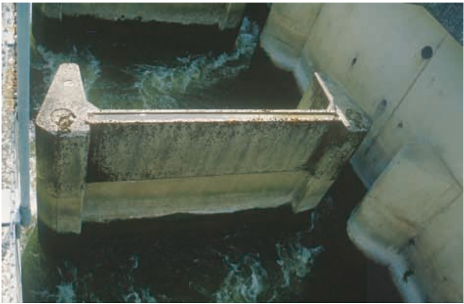
图 5.15 多尔多涅河（法国）上的贝尔杰拉克堰旁的狭槽鱼道 ( h_{\text{tot}} = 4.0 \text{ m} , b = 6.0 \text{ m} , l_b = 4.5 \text{ m} , l_{\text{tot}} = 73 \text{ m} , Q = 2.2 \sim 7 \text{ m}^3/\text{s} , 通过旁路水道的补充流量 0 \sim 6 \text{ m}^3/\text{s} 。建造年份, 1984 年)。这类结构证明对大型鲑科鱼类和有经济意义的西鲱 ( Alosa alosa ) 及鲤科鱼类都适合
