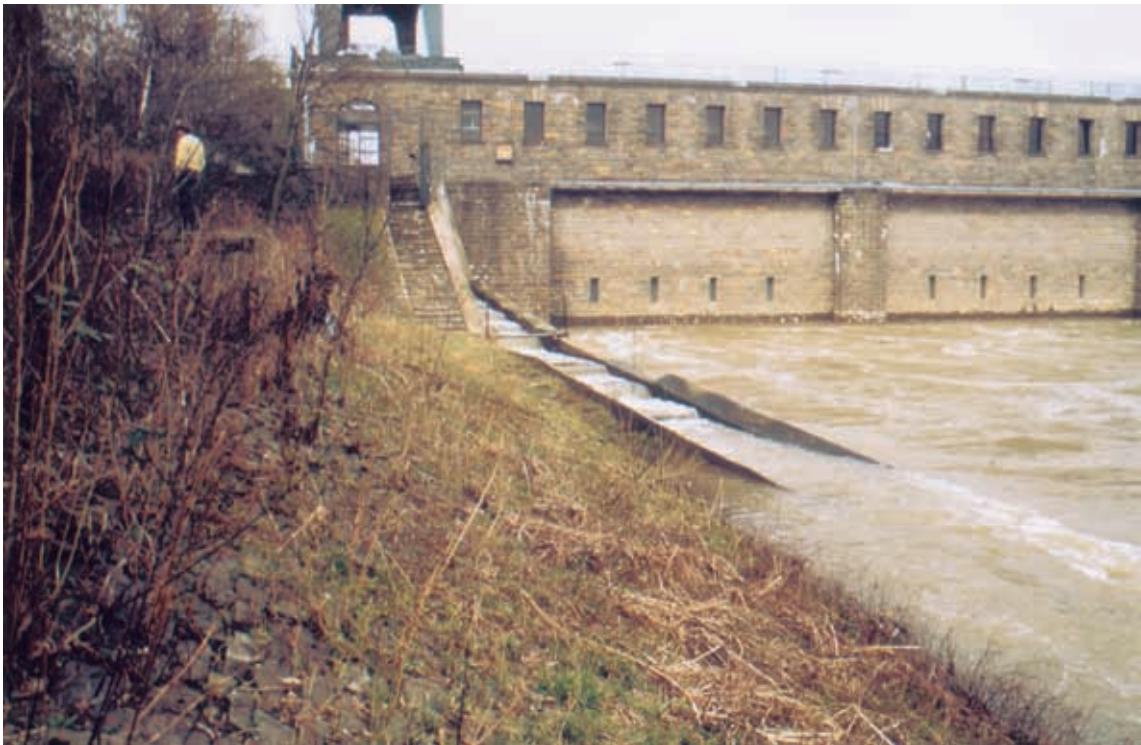
图 5.11 科布伦茨/摩泽尔鱼道（下游水视图）。该坝的鱼道位于摩泽尔右岸水电站旁，于 1951 年投入运行。GENNERICH（1957）、PELZ（1985）和其他人检查了该鱼道的运行。虽然大量的鱼能够通过该鱼道，但在靠近涡轮机出口附近捕获的鱼多得多，显然是因为它们找不到鱼道的入口。试验表明，鱼道入口和涡轮机出口的距离约为 45m，这是因为鱼道太长，约 102m，应是问题所在。
