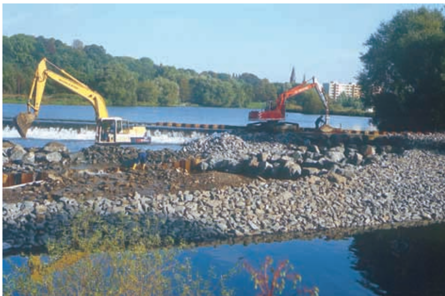
图 4.40 斯皮伦堡堰；施工中的鱼坡
