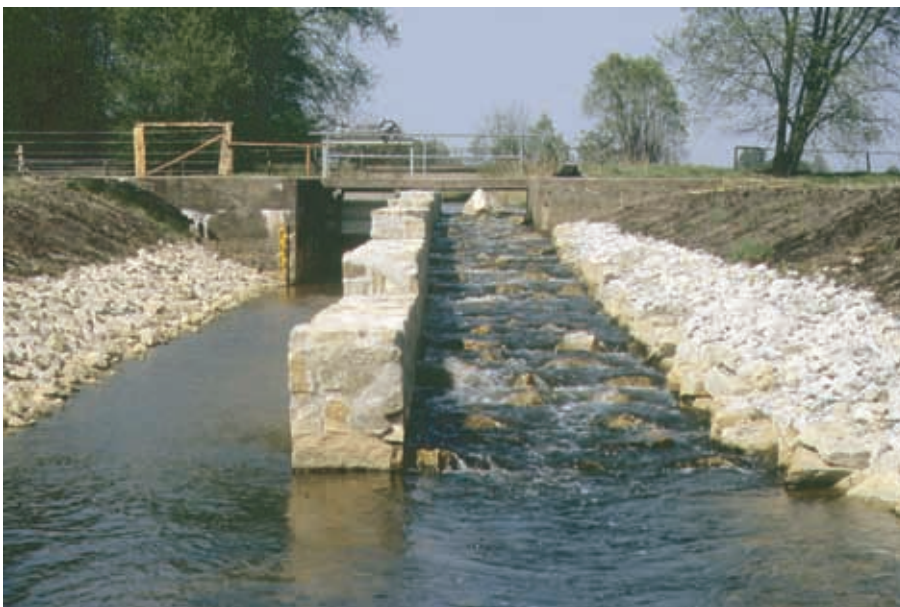
图 4.28 本例中，鱼坡取代了左手堰槽，总流量达到平均流量，是通过鱼坡传送的，该鱼坡设计采用了抗扰动蛮石偏置的、粗糙水道形式。坡体是一个填石构造。石头砌的矮墙将鱼坡与无障碍堰区分开。克雷韦林堰，多林溪（勃兰登堡）
