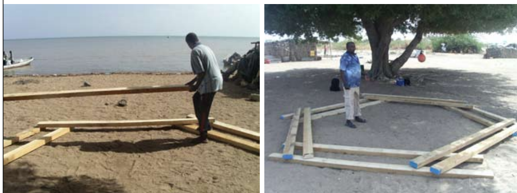
PLANCHE 20 Disposition des madriers supérieurs
