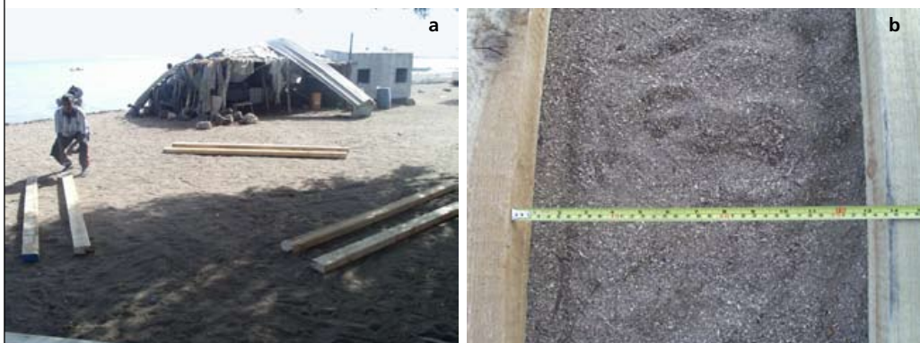
PLANCHE 19 Disposition des premiers madriers (a); Vérification de la distance entre les madriers parallèles (b)
