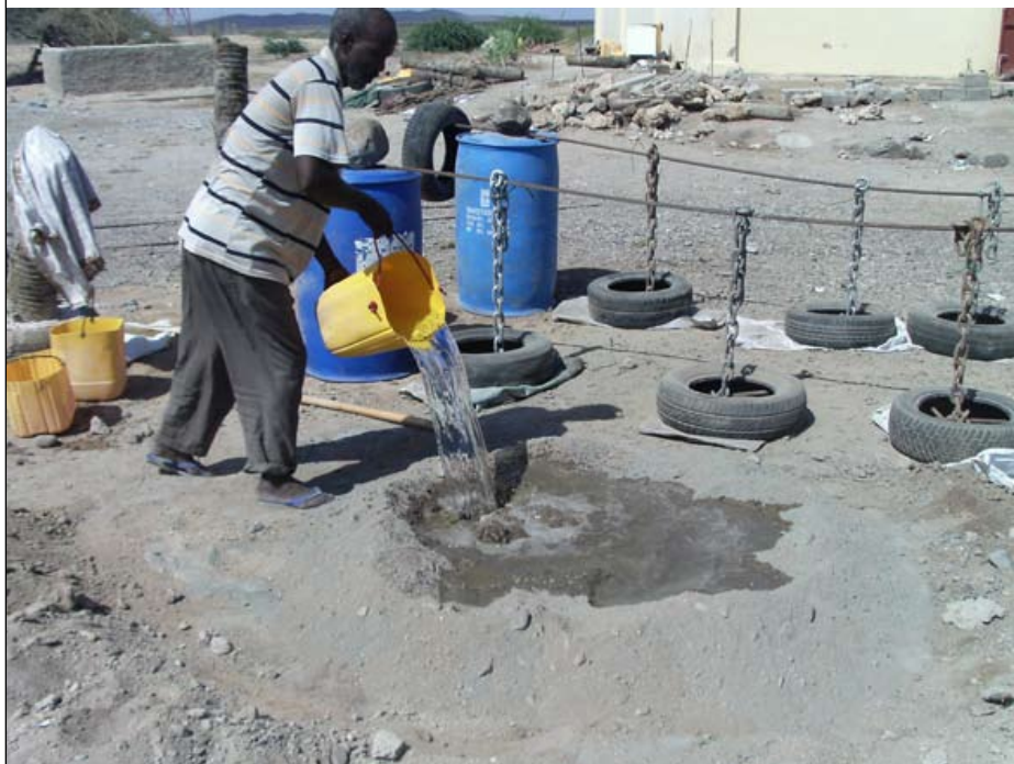
PLANCHE A3.1 Mélange du béton
