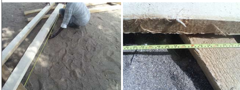
PLANCHE 21 Vérification de la longueur des côtés
