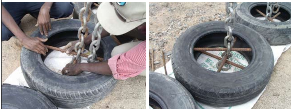
PLANCHE 15 Barres de fer croisées dans les pneus
