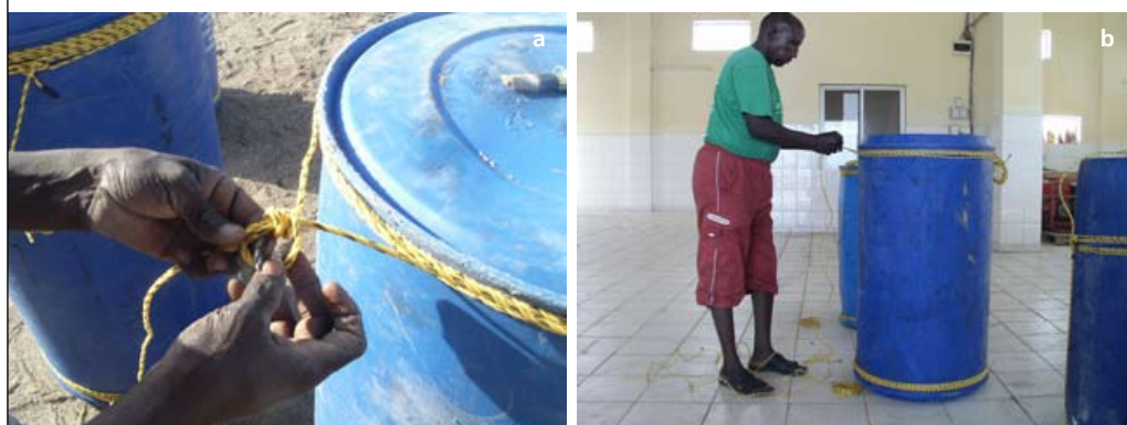
PLANCHE 26 Ligature à effectuer sur les fûts (a); On a trois extrémités libres, la quatrième corde vient d'être ajoutée dans le côté inférieur droit (b)
