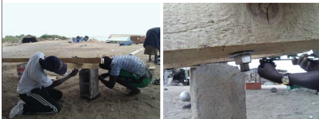
PLANCHE 24 Serrage des écrous
