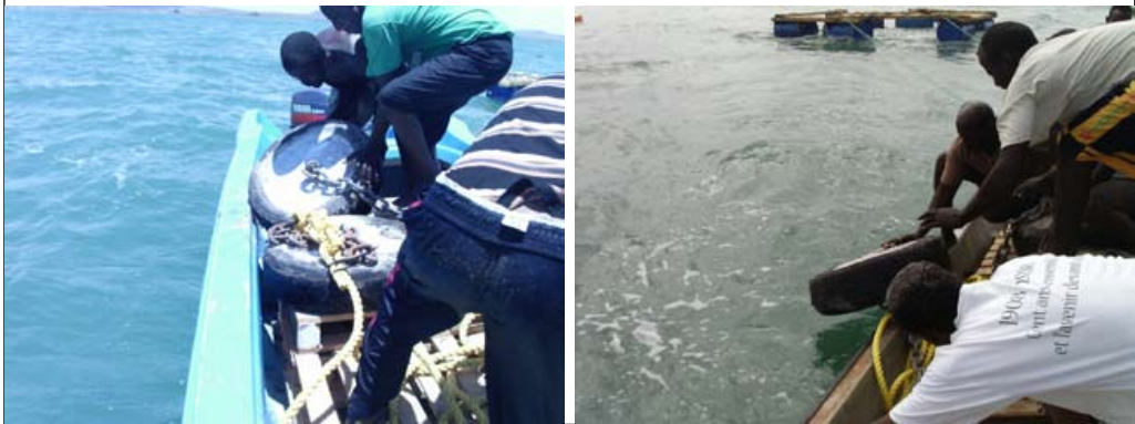
PLANCHE 38 La mise à l'eau des corps-morts
