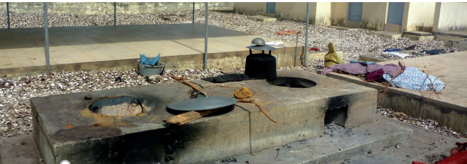
Fours améliorés construits sur le site de Médina, Sénégal, permettant de réduire la consommation de bois. (en arrière plan vue sur une aire de travail et sur le bloc douches.) © FAO/L. Roy
