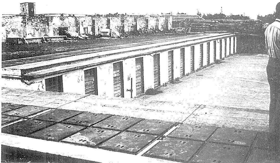
Fig. 4 Depósito de composte para la fermentación de las basuras urbanas. Fu Shan, Provincia de Guangdong.
