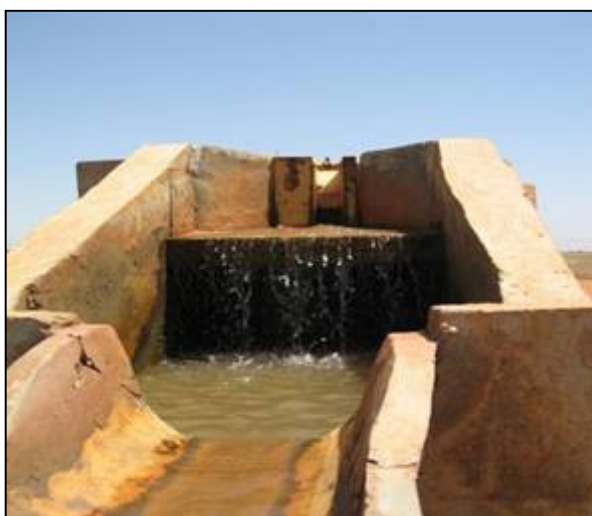
Planche 4. Autre exemple de pertes constatées sur le réseau : au niveau de joints défectueux entre éléments préfabriqués (gauche) ou au niveau des vannes et martelieres (droite)
