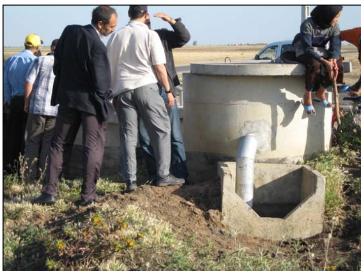
Planche 2. Borne Basse Pression desservant un tertiaire
