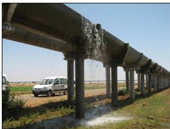
Planche 3. Exemple de pertes constatées sur le réseau: à gauche une perte sur un canal autoporté présentant un élément défectueux ; à droite surverse due à l'absence de revanche (capacité insuffisante du canal par rapport au débit nominal)
