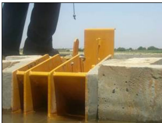
Planche 9. Régulateur de niveau à long seuil fixe (gauche), modules à masques (droite).
