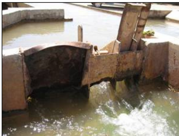
Planche 5. Sac de sable remplaçant la martelière (gauche), module à masque dégradé (droite).
