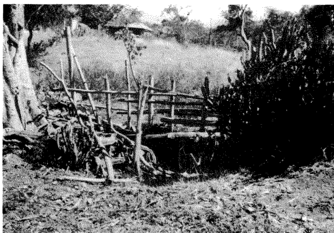
Construction d'un seuil en bois repousse (ici, des gommiers - Plaine d'Aquin 1987)
