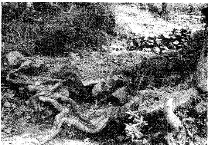
Rôle de la végétation : racines consolidant le fond d'une ravine à l'aval d'un seuil en pierres sèches (Calumettes 1986)
