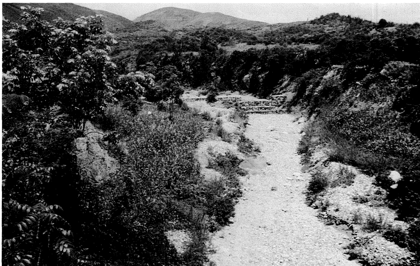
Lit large et encombré d'alluvions de la ravine de Sedren. Terrasses non stabilisées et cultivées. Au fond, un seuil en gabions, 1986
