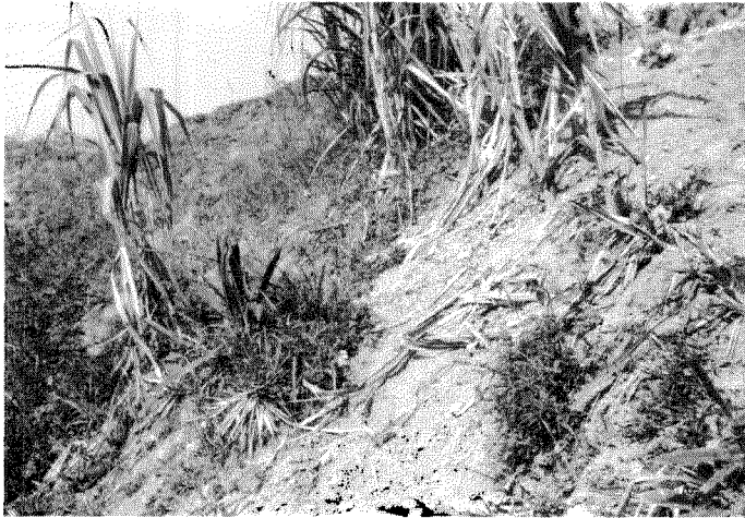
Canal de contour planté avec de la canne à sucre sur versant à forte pente : un glissement superficiel a entraîné une partie de la plantation (La Vallée 1986)
