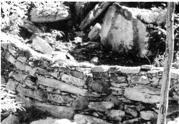
Seuil en pierres sèches dans une petite ravine (Marigot 1985)
