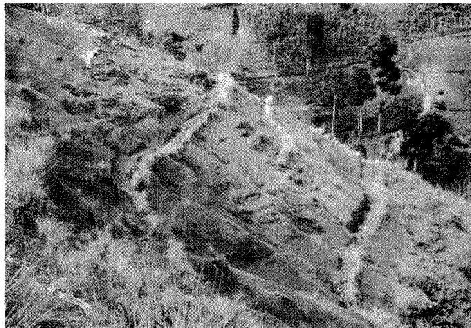
Canaux de contour sur un versant sur basalte très dégradé (té fini) et à forte pente (La Vallée 1986)
