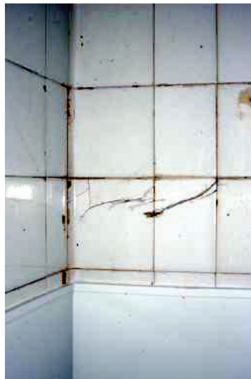
FOTO 10.4 EVITE: mosaicos cuarteados: pueden alojar microorganismos.
