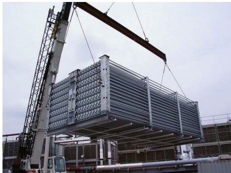
Herse de bac à glace Ice on tube cold storage device
