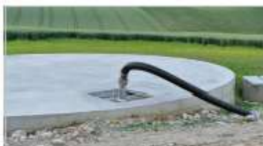
Fosse sous dalle
