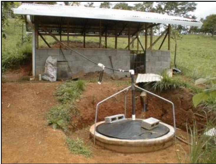
José Luis Zúñiga ha comprobado los beneficios del biodigestor en su finca de La Legua, Puriscal, Costa Rica donde con 4 cerdos sostiene un biodigestor de campana que le suministra gas para la cocina y fertilizante orgánico. Foto, J. Mora, 2000
