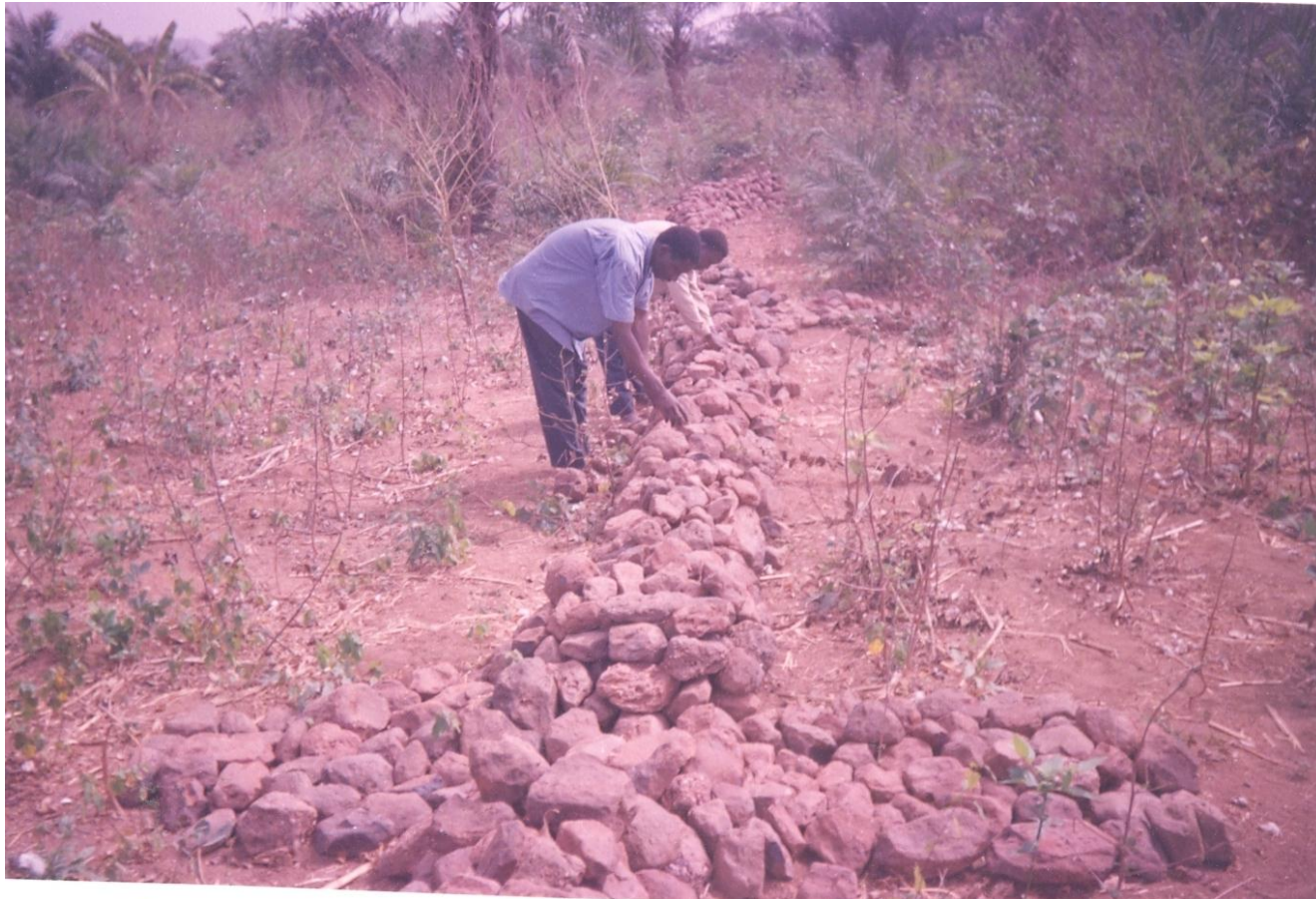
Diguette en pierres sèches
