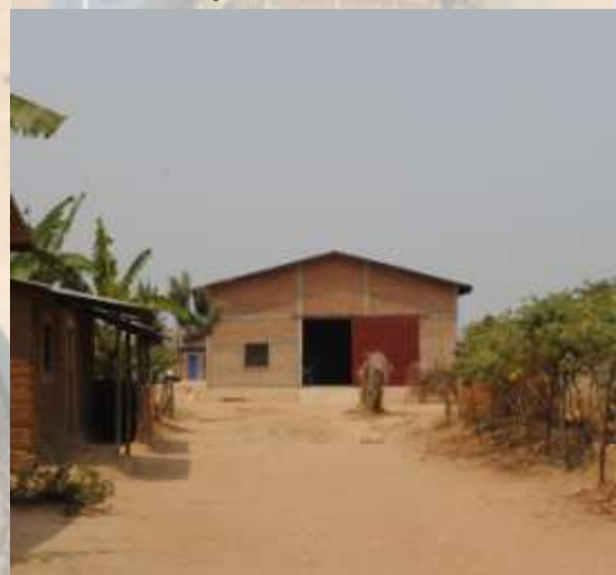
Un des hangars de stockage construits par la FAO
