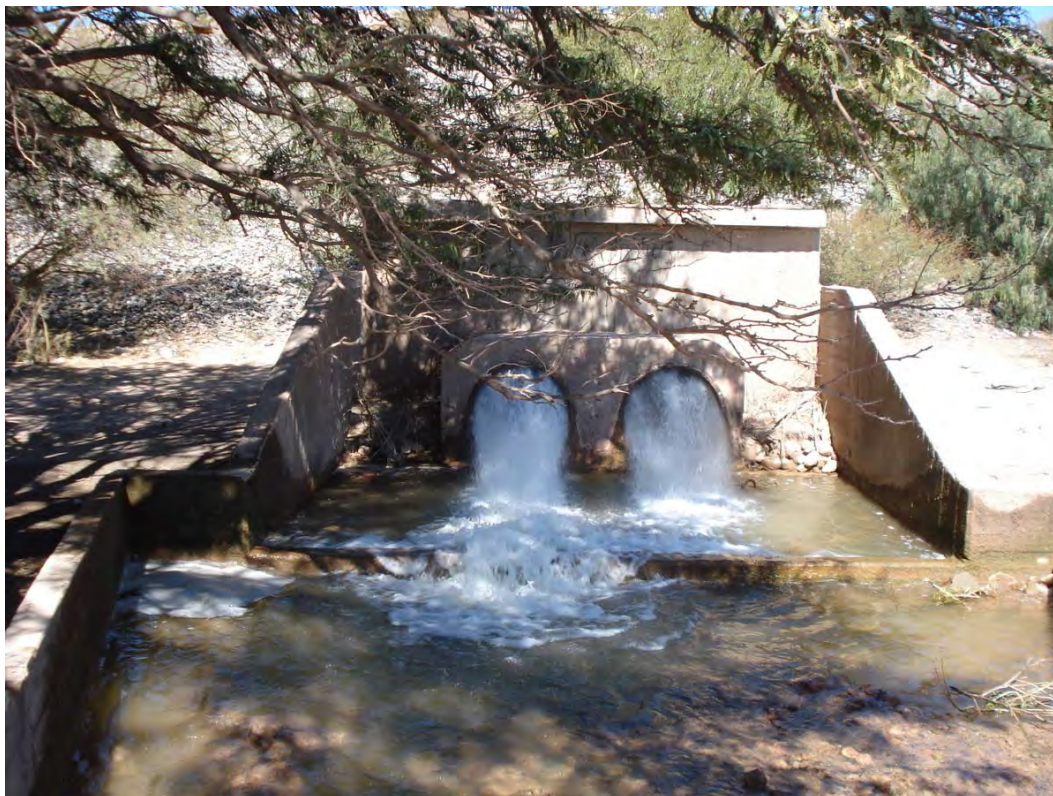
Figura N°7. Canales de salida y cámara aquietadora en dique La Dársena
