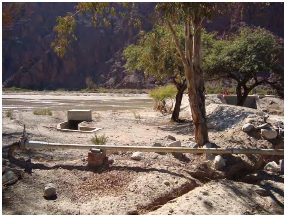
Figura N°4. Cámara de salida. Sifón cruce Río Calchaquí. Canal proveniente toma Palo Pintado.
