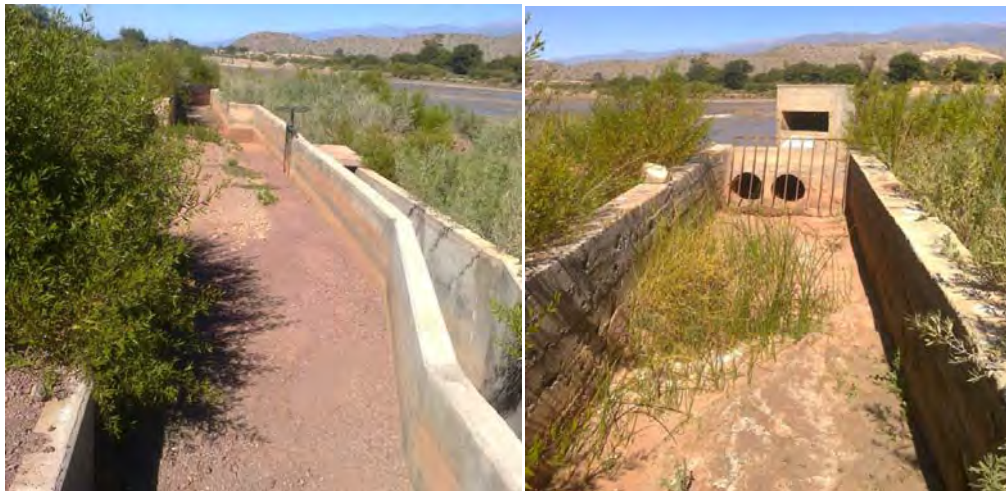
Figura N°15. Desarenador y cámara de ingreso al sifón de cruce sobre margen izquierda.
