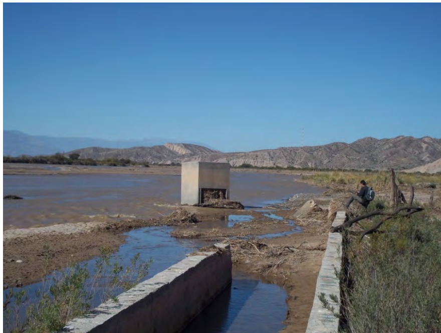
Figura N°13. Estado actual del canal y cámara de ingreso al sifón de cruce a margen izquierda.
