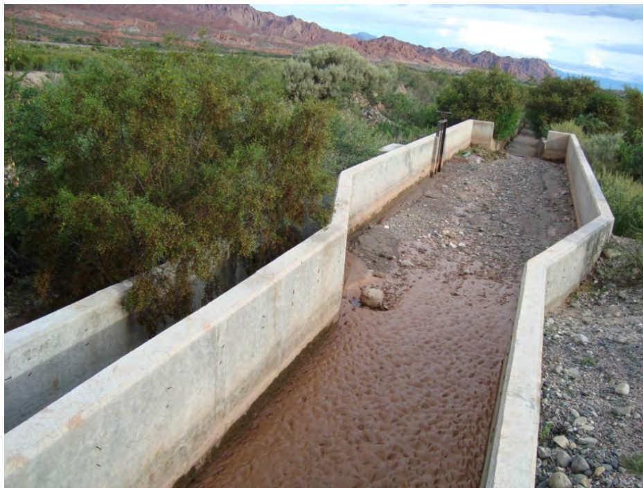
Figura N°12. Desarenador
