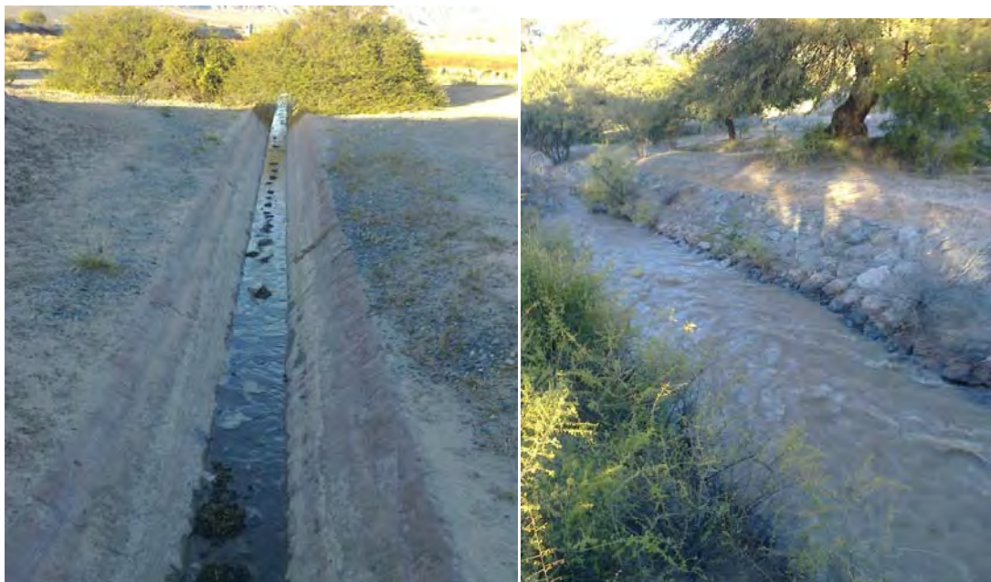
Figura N°30. Estado del canal en La Dársena – San Carlos
