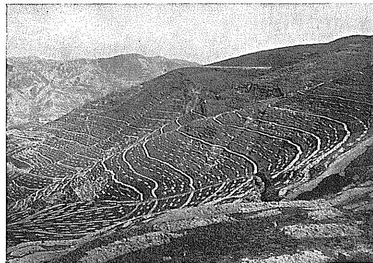
Gubbio (prov. di Perugia). — Bacino montano del Torrente Camignano. Versante destro del Fosso del Calcinaro. Lavorazione del terreno a gradoni e piazzole.
