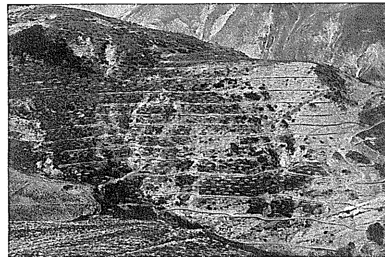
Gubbio (prov. di Perugia). — Torrente Camignano. Sottobacino del Calcinaro. Esposizione Nord, parte mediana. Come indica la fotografia, la sistemazione a gradoni interessa una pendice ripidissima in piena dissoluzione.
