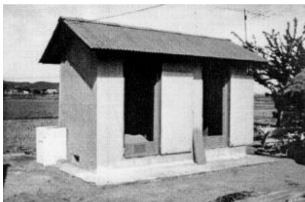
Figure 5. SSBT utilisant une structure existante alors que le silo est en construction aux Philippines.
