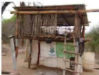
Troje rústico mejorado con techo de calamina y placas de metal antirratas en las patas de apoyo
