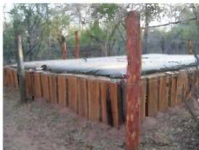
Geo-membrana de almacenamiento de agua, alimentada con un pozo profundo (dotada por la gobernación de Chuquisaca), conectada al bebedero de los animales
