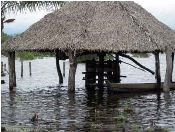
Viviendas vulnerables a inundación
