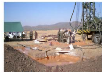
Maquinaria en Pleno Trabajo
