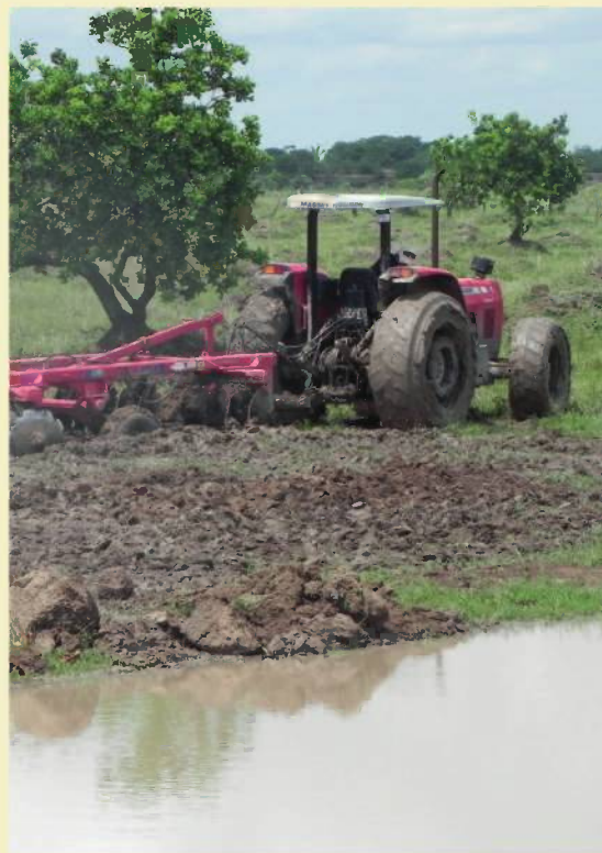
Construcción de loma de resguardo en Santa Ana del Yacuma
