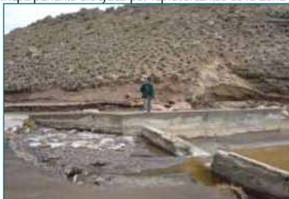
Toma de riego mejorado (Toma 12 Picañani)
