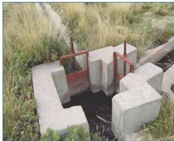
Fotografía 4. Obras de conducción y repartición
