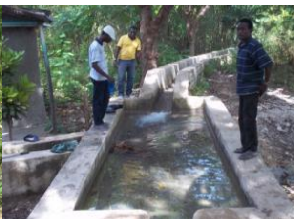
Photo : Canal d'irrigation du système de Préchet/Belle Anse
