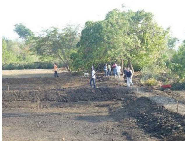
Bassin d'alevinage creusé par les membres du CEP Robino – Mai 2014
