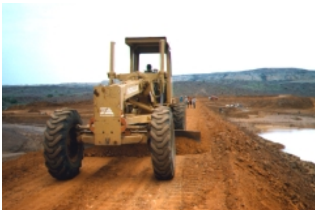
PLATE 7.3 Fill spreading
