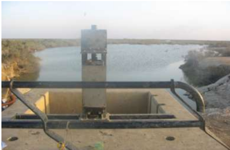
Photo 2 : Aménagement d'un barrage de retenue d'eau au PND, IMROP 2010
