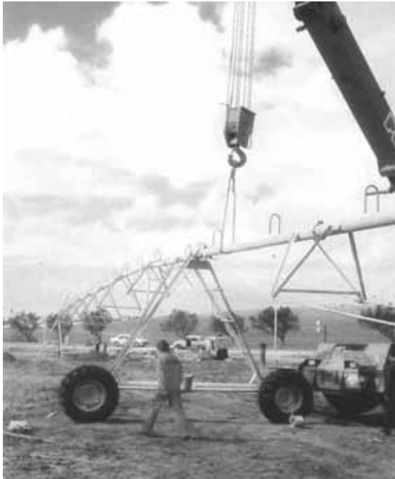
FIGURE 10.7 - Le montage du pivot central.
