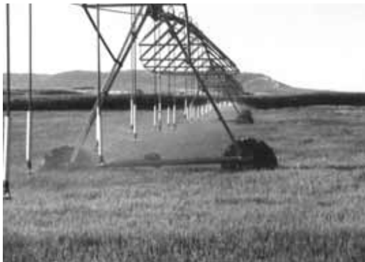
FIGURE 10.3 - Tubes suspendus avec mini-diffuseurs.
