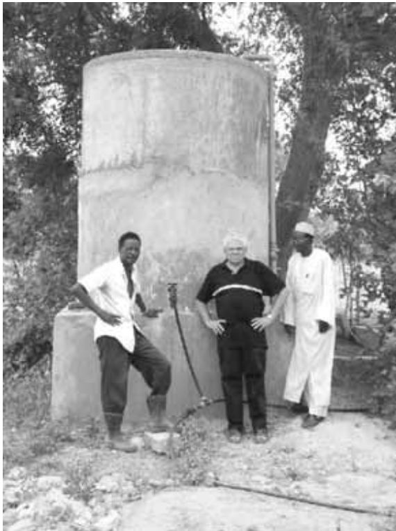
FIGURE 15.3 - Réservoir fabriqué localement pour un système familial d'irrigation goutte-à-goutte.
