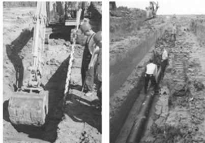
FIGURE 17.2 - Installation des conduites.
