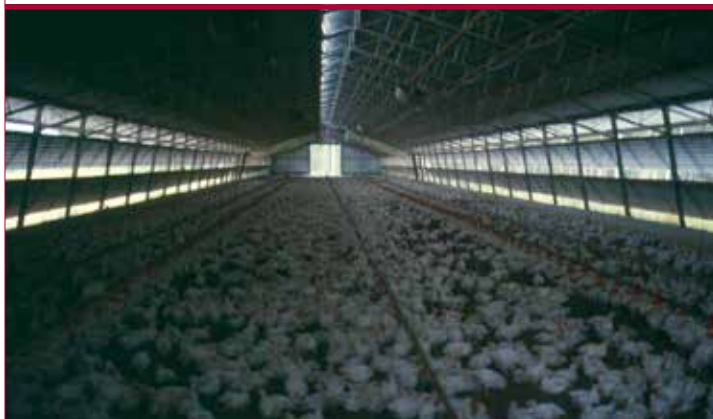
Alojamiento de pollos de engorde de gran escala con ventilación natural
