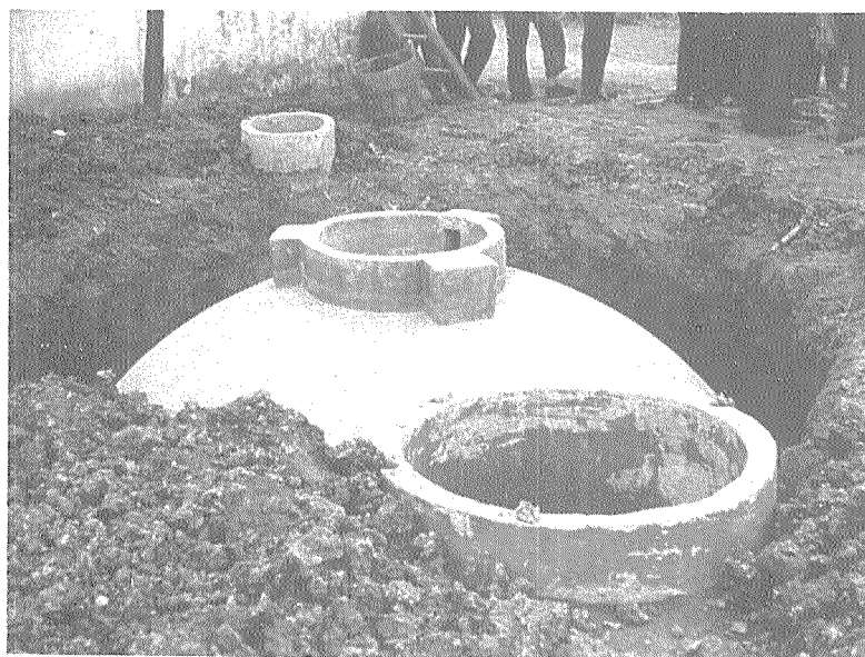
Fotografía 23. La unidad de biogas que se ve en construcción en las fotografías 21 y 22 después de su enlucido inicial. La salida está en el plano anterior y la entrada en el posterior.
