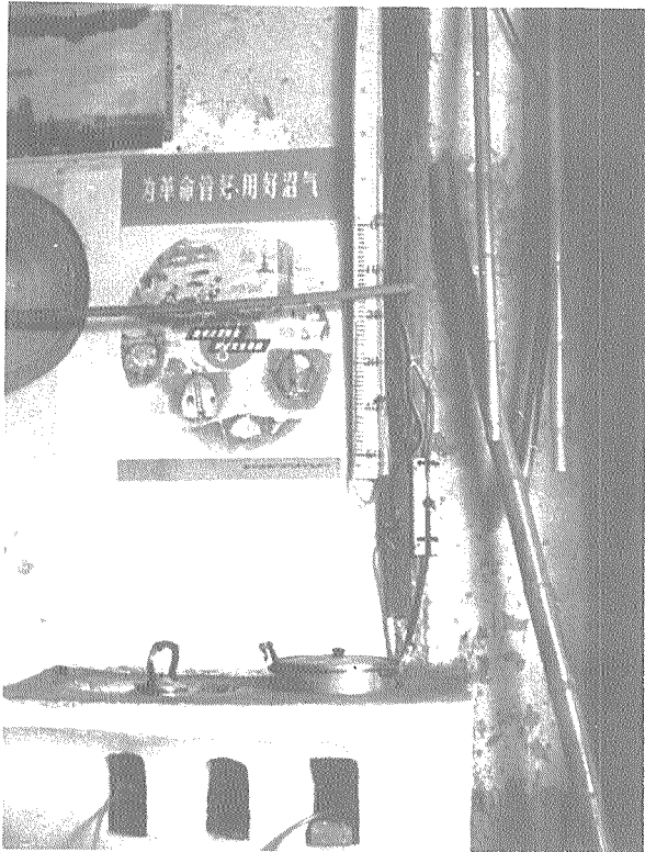
Fotografía 32. Cocina china con los quemadores de biogas en hogares profundos para obtener el máximo rendimiento.
