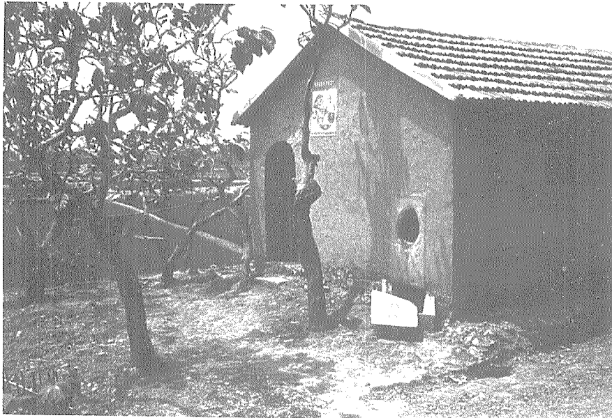
Fotografía 19. Exterior de la cochiguera de la Fotografía 18, en la que se ve una salida en la pared para echar los desechos domésticos a la unidad de biogas y, en el suelo, la salida de la unidad de biogas.
