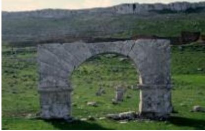
Site Kouchbatia Monument : Cinq portes Identifiant Monument : 31-5 Date de classement : 1 mars 1915
