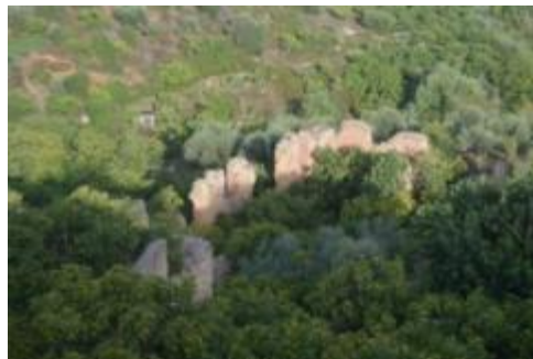
Site : Djebba Monument : Aqueduc romain Identifiant Monument : 31-18 Date de classement : 1 mars 1905
