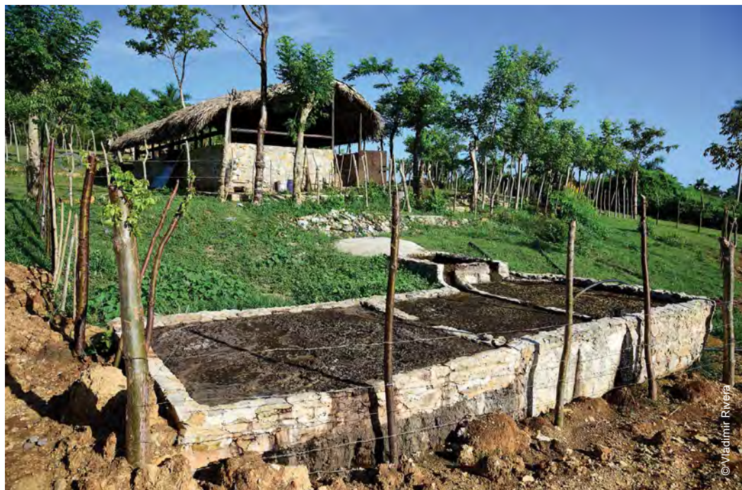
Recolección de efluentes procesados en el biodigestor y provenientes de la vaquería.
