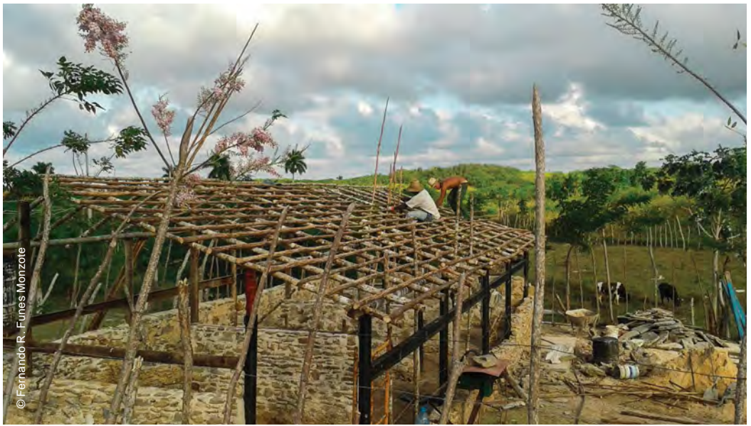
Construcción de una nave rústica para ganado con (capacidad máxima: veinte animales).
