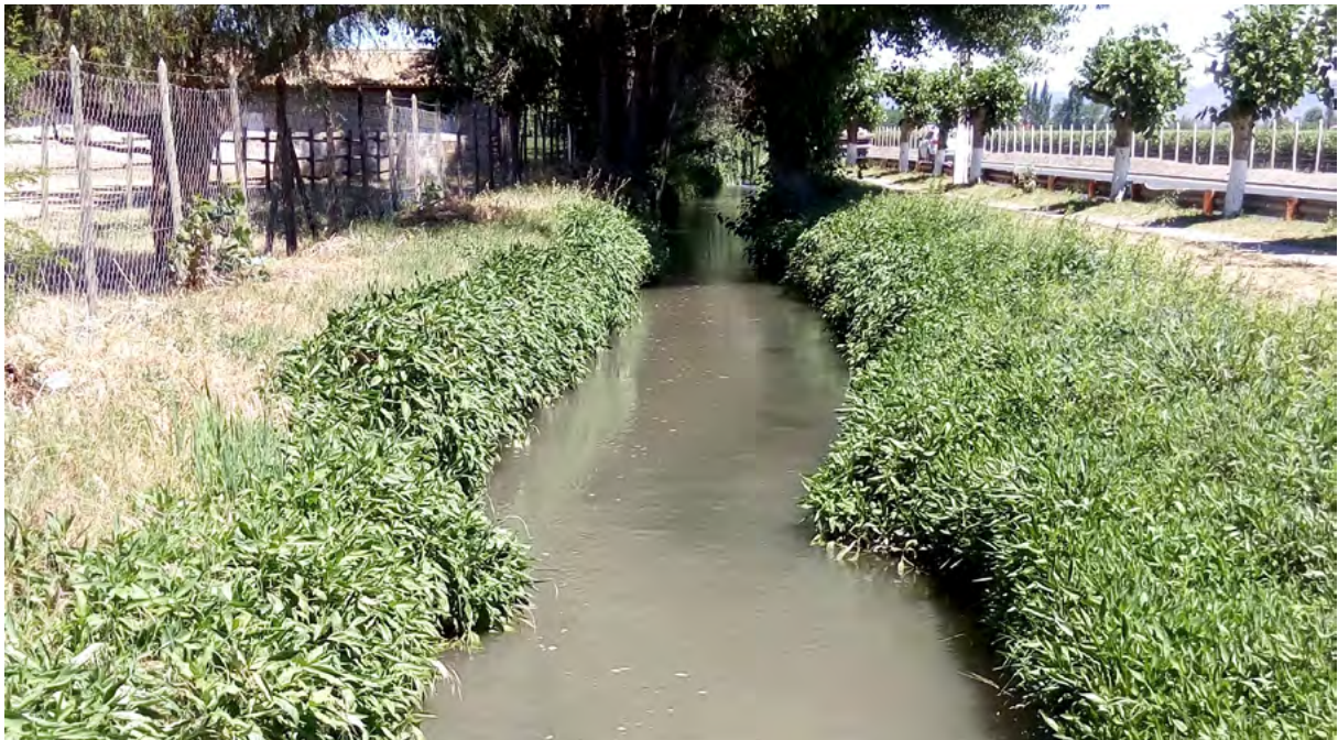
Figura 20. Canales sin revestir en la subcuenca
