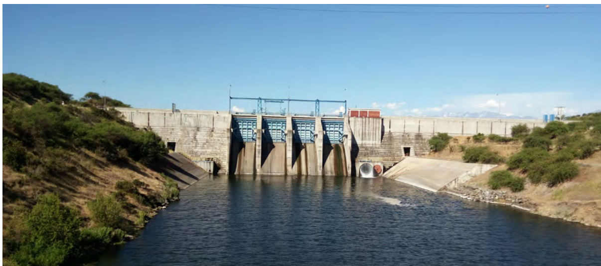
Figura 12. Muro del embalse Convento Viejo (arriba) y cauce aguas abajo (abajo)
