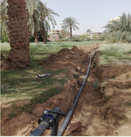
كيفية اعاده تأهيل الاراضى التى تروى بالغمر الى طريقه الري بالتنقيط
