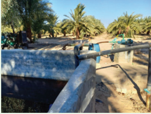
كيفية سحب السماد العضوى السائل بواسطة السماده ودفعه الى شبكه التنقيط
