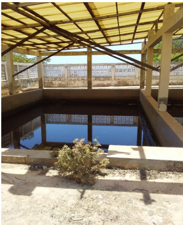
FIGURE 19: BASSIN DE DEGORGEMENT DE KATAKA LOUSSE
