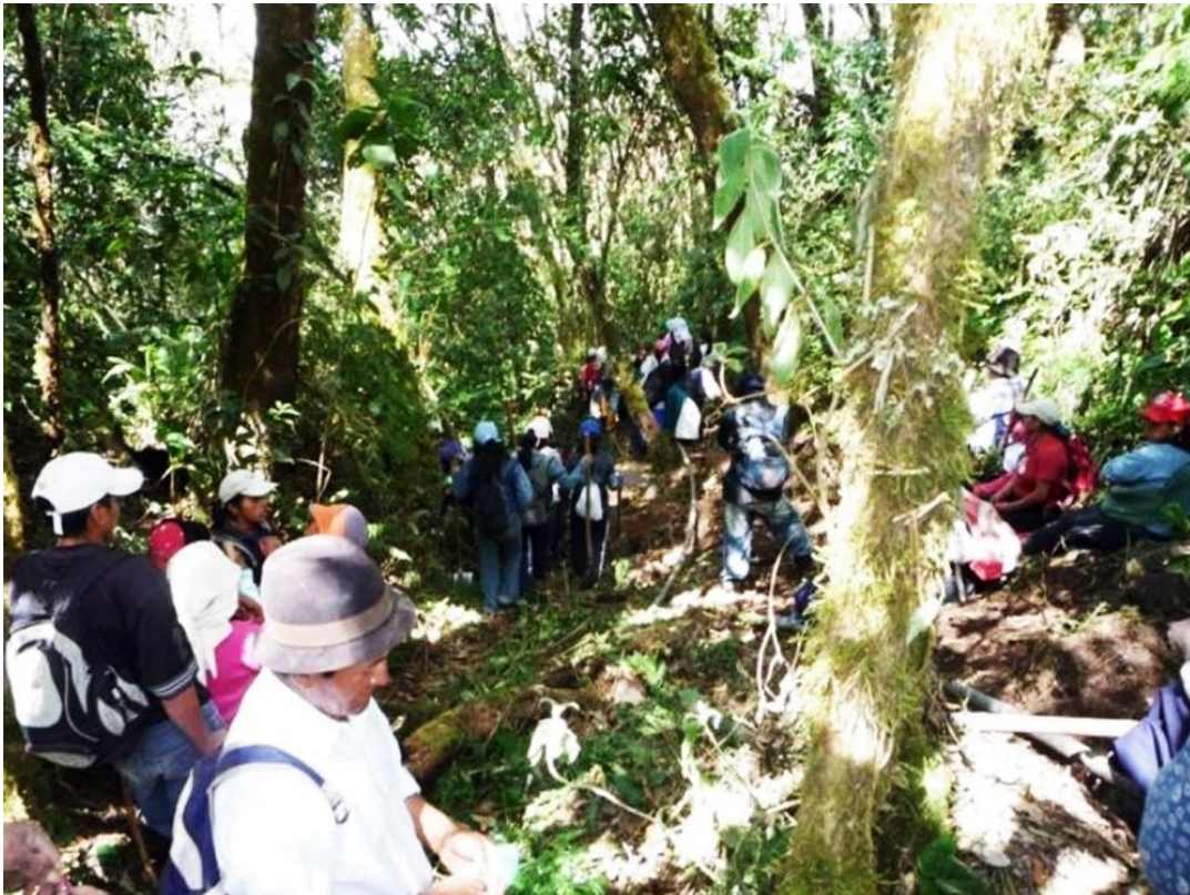
Indígenas de la comuna El Morlán trabajando en la minga para instalar el sistema de agua. Fuente: UNORCAC
