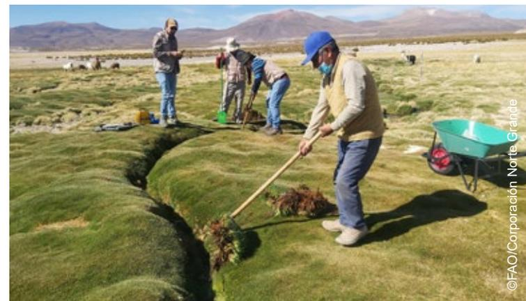
Figura 8. Rectificación de canal con champeras, azadón y serrucho (sector Jalsure, Cancosa), comuna de Píca.
