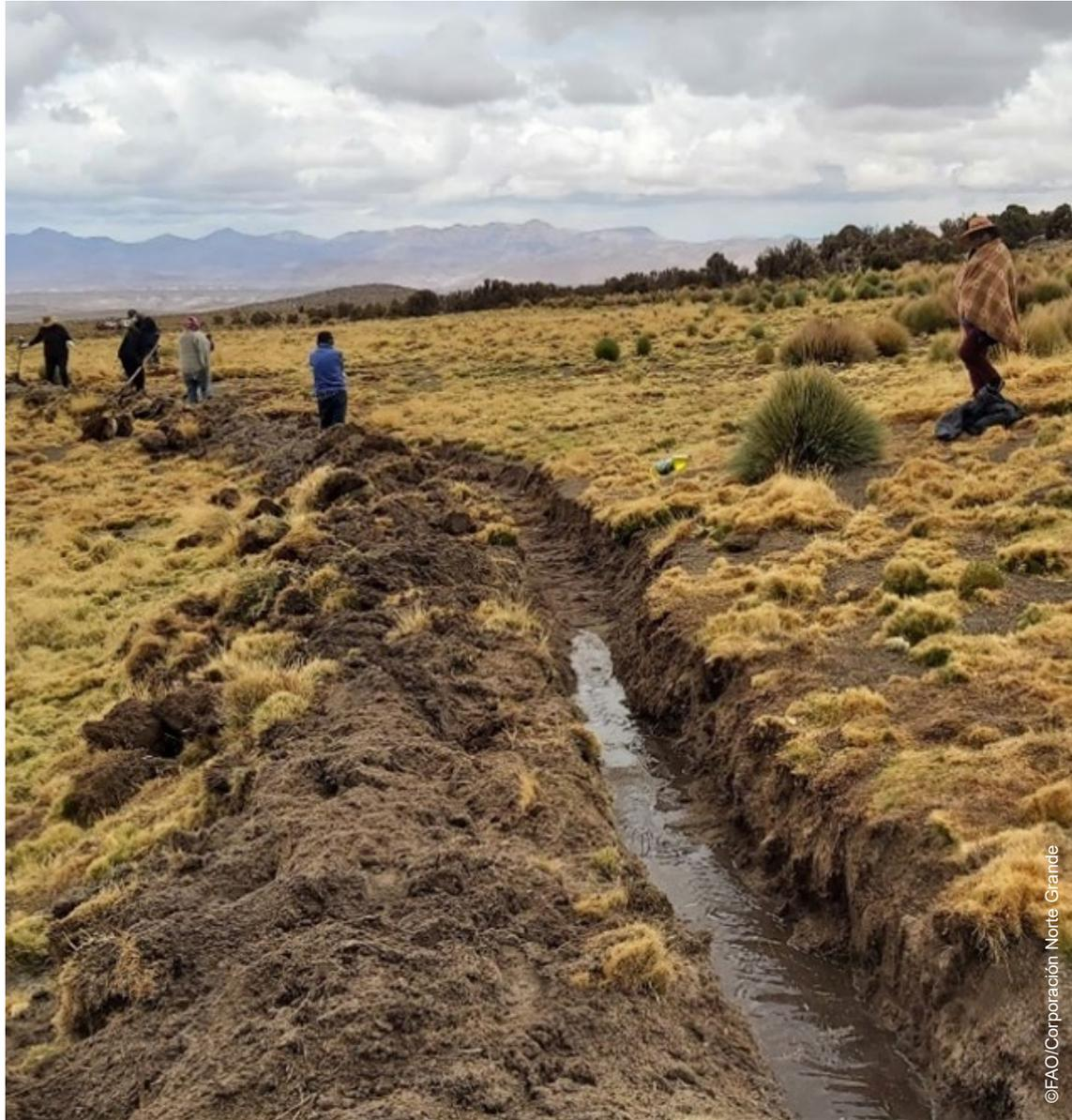
**Figura 6.** Construcción de canal de regadío en el sector de Puquio, en Guallatire, comuna de Putre.
