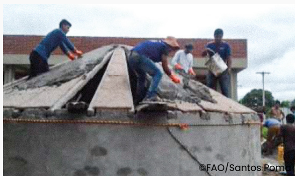
Imagen 10. Techado de la cisterna en Charagua
