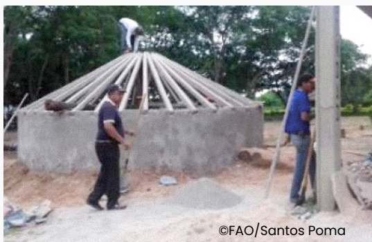
Imagen 10. Techado de la cisterna en Charagua
