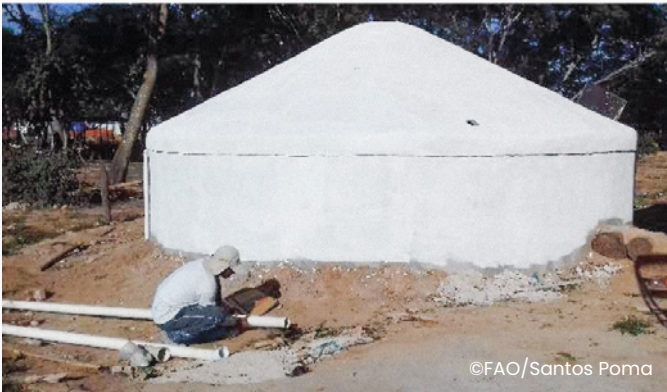
Imagen 11. Se realizaron las instalaciones y el pintado de la cisterna
