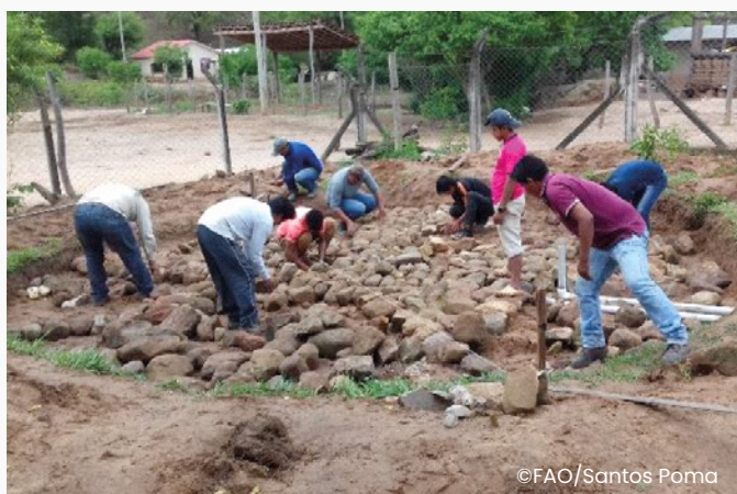
Imagen 5. Cavado, empedrado y armado de la parrilla de fondo-Masavi
