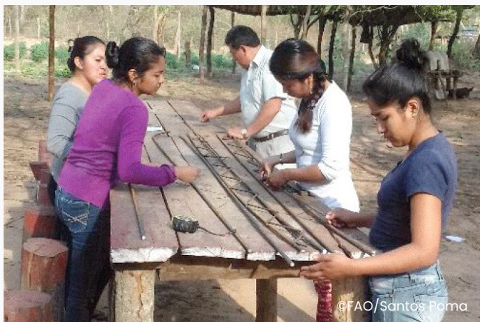
Imagen 1. Se elaboraron viguetas en la Escuela Normal de Charagua.
