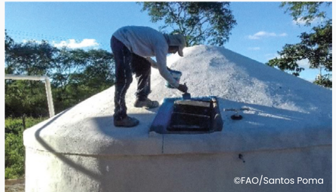
Imagen 12. Se realizaron las instalaciones y el pintado de la cisterna
