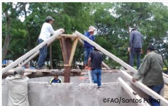
Imagen 10. Techado de la cisterna en Charagua
