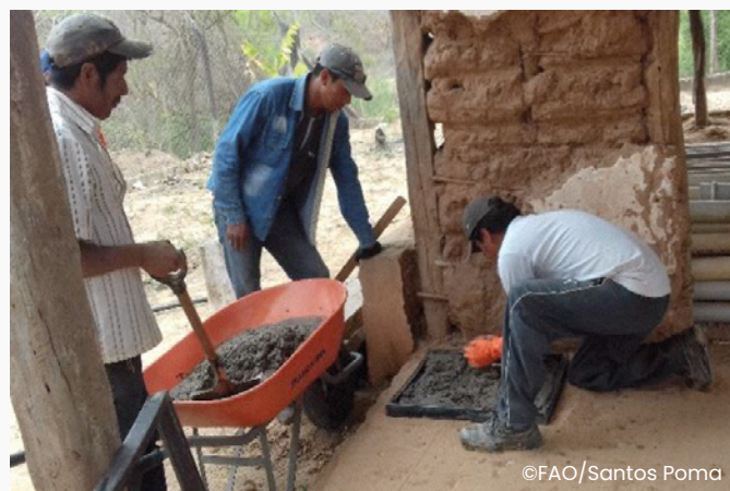
Imagen 4. Se elaboraron placas de pared en la Escuela Normal de Taputá.
