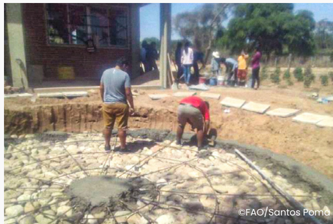
Imagen 7. Se realizó el vaciado de la faja de fondo y el nivelado
