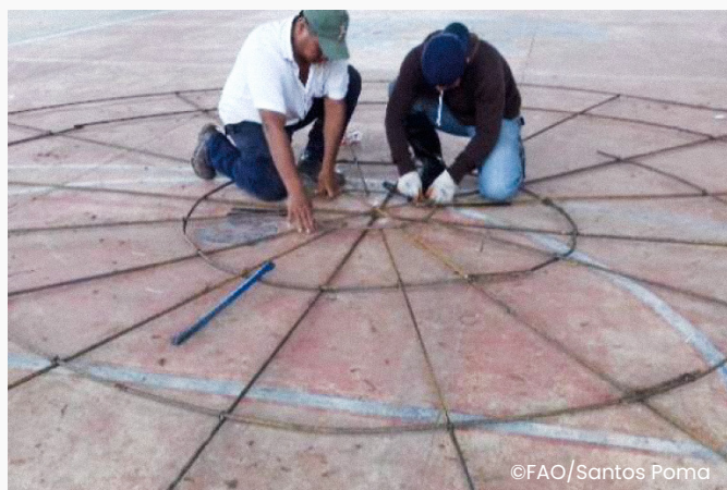
Imagen 6. Cavado, empedrado y armado de la parrilla de fondo-Masavi
